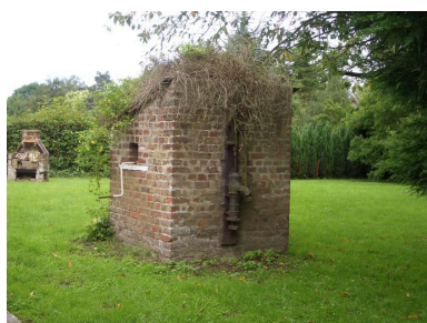
Vue du puits. Phot. Inès Guérin IVR22_20078005129NUCA
