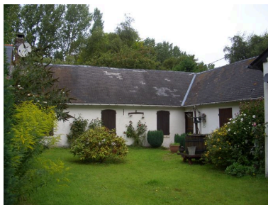
Vue depuis la cour sur le logis. Phot. Inès Guérin IVR22_20078005127NUCA
