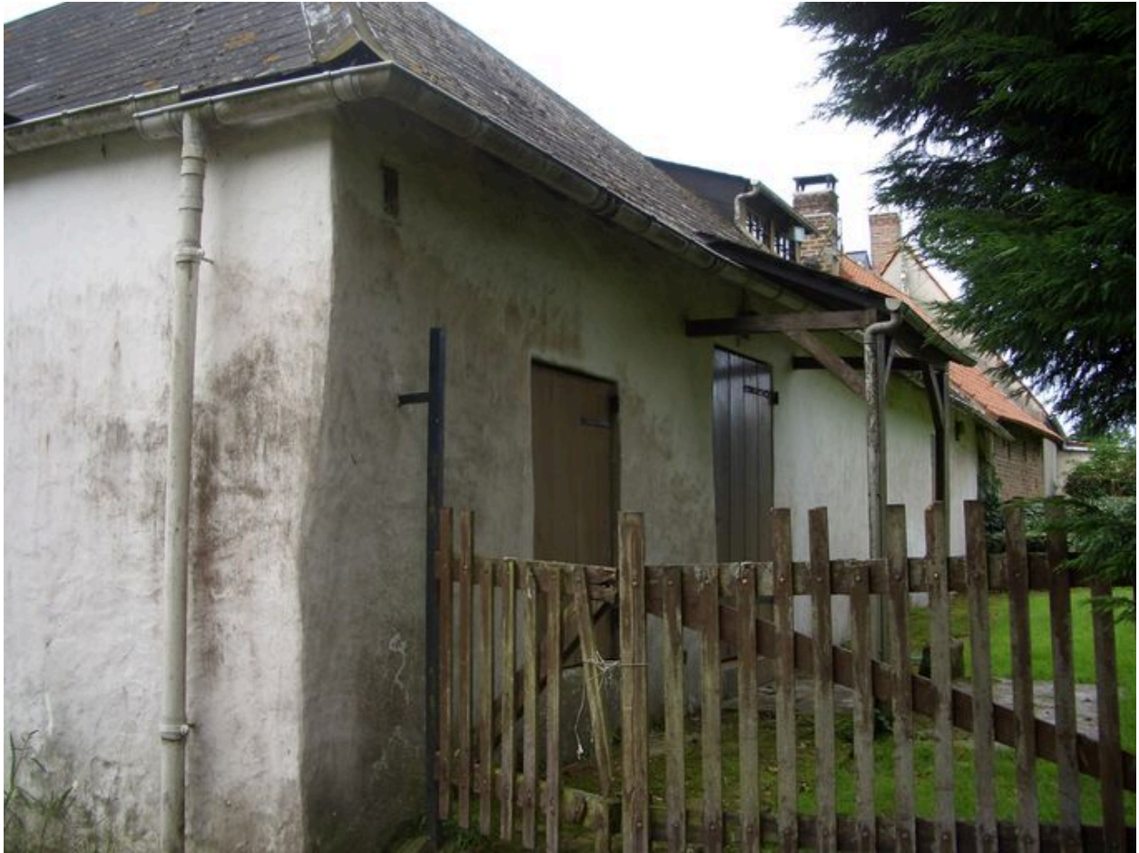
Vue postérieure des dépendances et du logis au fond.
