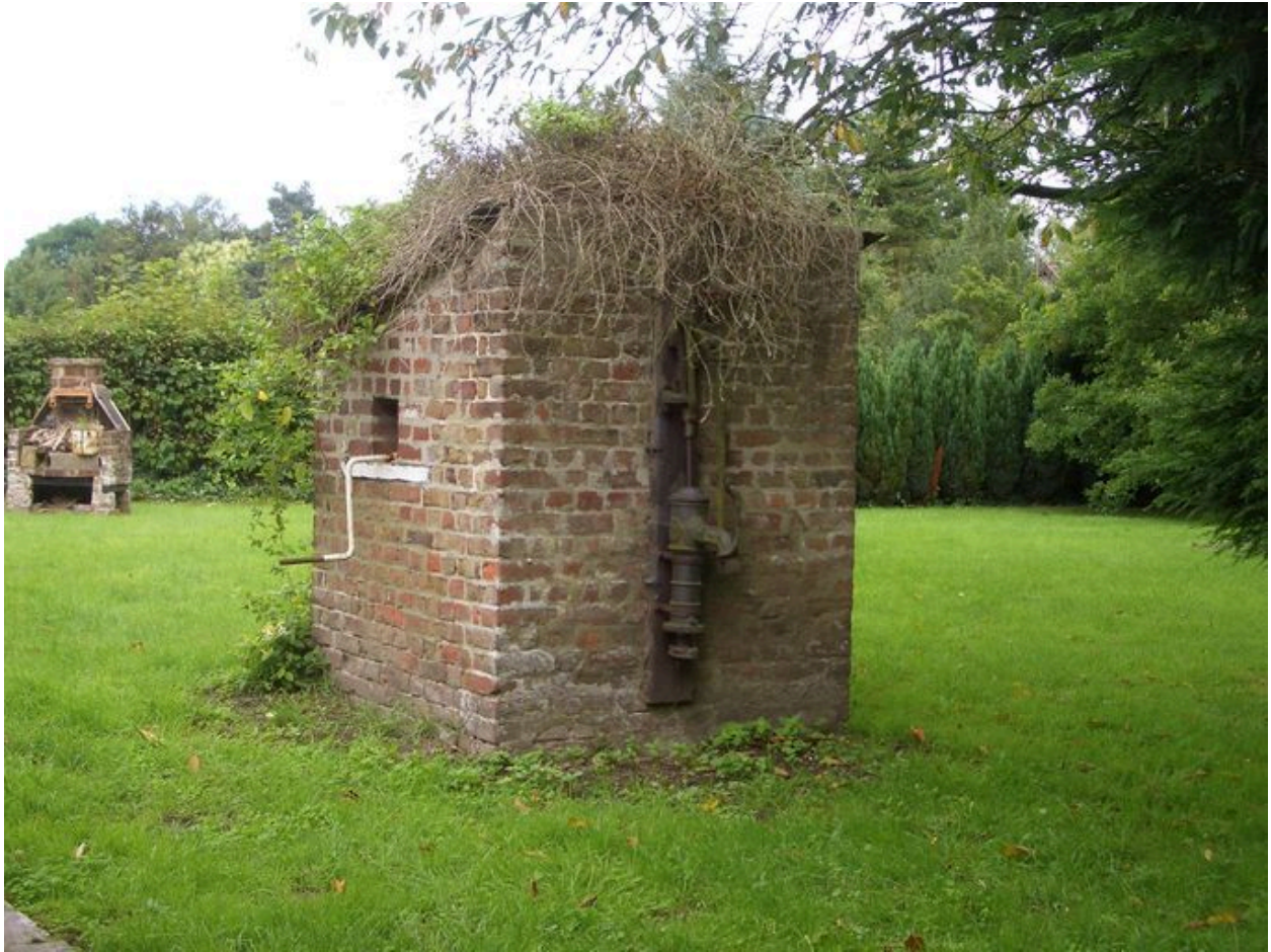
Vue du puits.
