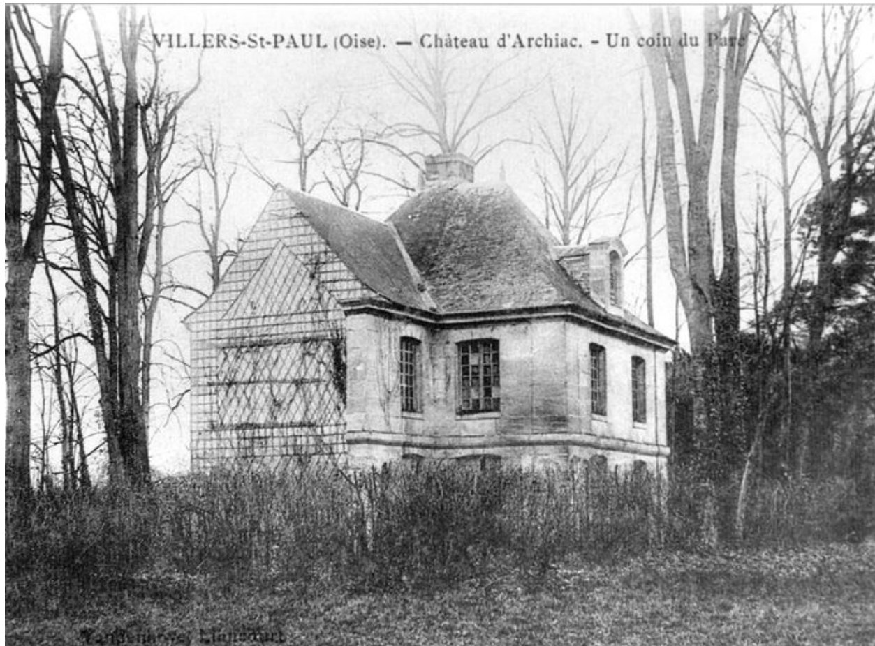
L'un des pavillons du château dans le parc au début du 20e siècle (AC Villers-Saint-Paul ; non coté).
