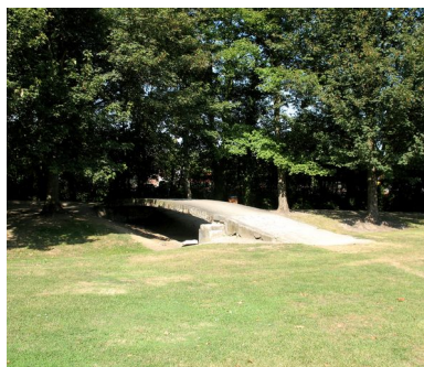
Vue du pont dans l'ancien parc du château. Phot. Clarisse Lorieux IVR22_20096005135NUCA
