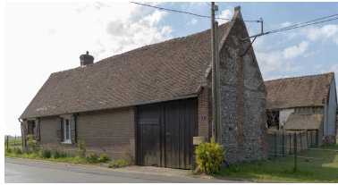
Ancienne ferme, n°2 rue Claude, vue depuis le nord-ouest. Phot. Marc Kérignard IVR32_20216000262NUCA
