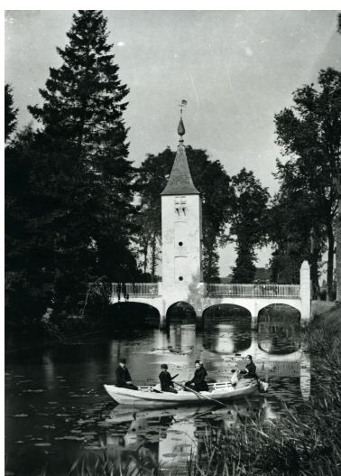
Pont du château de la Tour depuis le sud-est, photo noir et blanc, début XXe siècle (coll. Comité Flamand de France). Repro. Delphine Volto Jourdan IVR32_20255900355NUCAB
