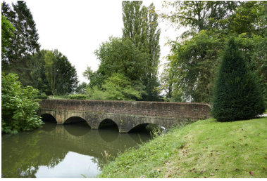
Vue du pont de brique depuis le sud-est. Phot. Delphine Volto Jourdan IVR32_20245903100NUCA
