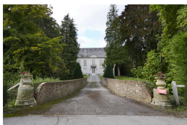
Vue vers la façade principale, avant le pont de brique. Phot. Delphine Volto Jourdan IVR32_20245903097NUCA
