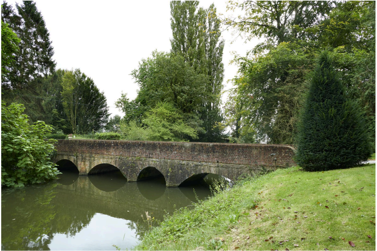
Vue du pont de brique depuis le sud-est.
