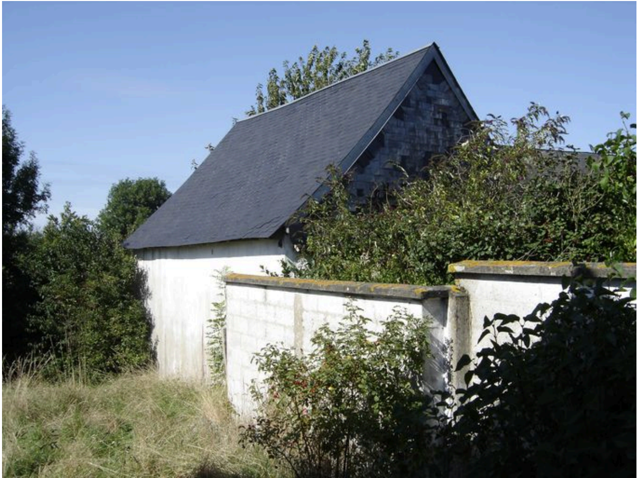
Vue postérieure des dépendances.
