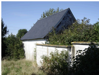
Vue postérieure des dépendances. Phot. Inès Guérin IVR22_20078005182NUCA
