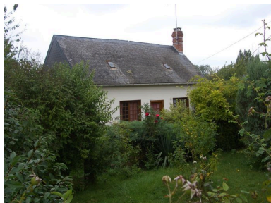
Vue du logis. Phot. Inès Guérin IVR22_20078005181NUCA
