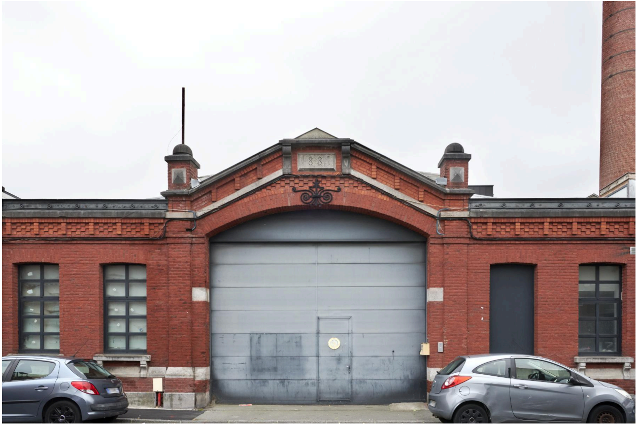
Détail du porche d'entrée d'origine, date gravée 1887, frise et fenêtres d'origine.
