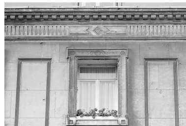
2e étage, travée centrale, fenêtre. Phot. Philippe Caudroit, Phot. Éric Dessert IVR31_19806204699X
