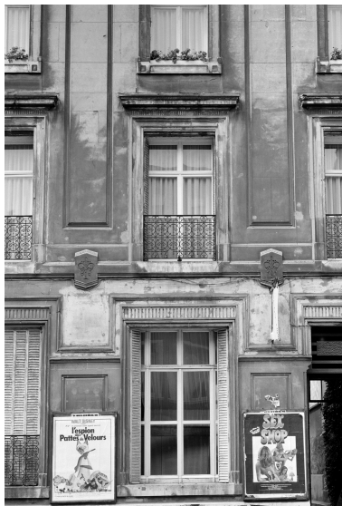
Rez-de-chaussée, 1er étage, travée centrale, fenêtres. Phot. Philippe Caudroit, Phot. Éric Dessert IVR31_19806204698X
