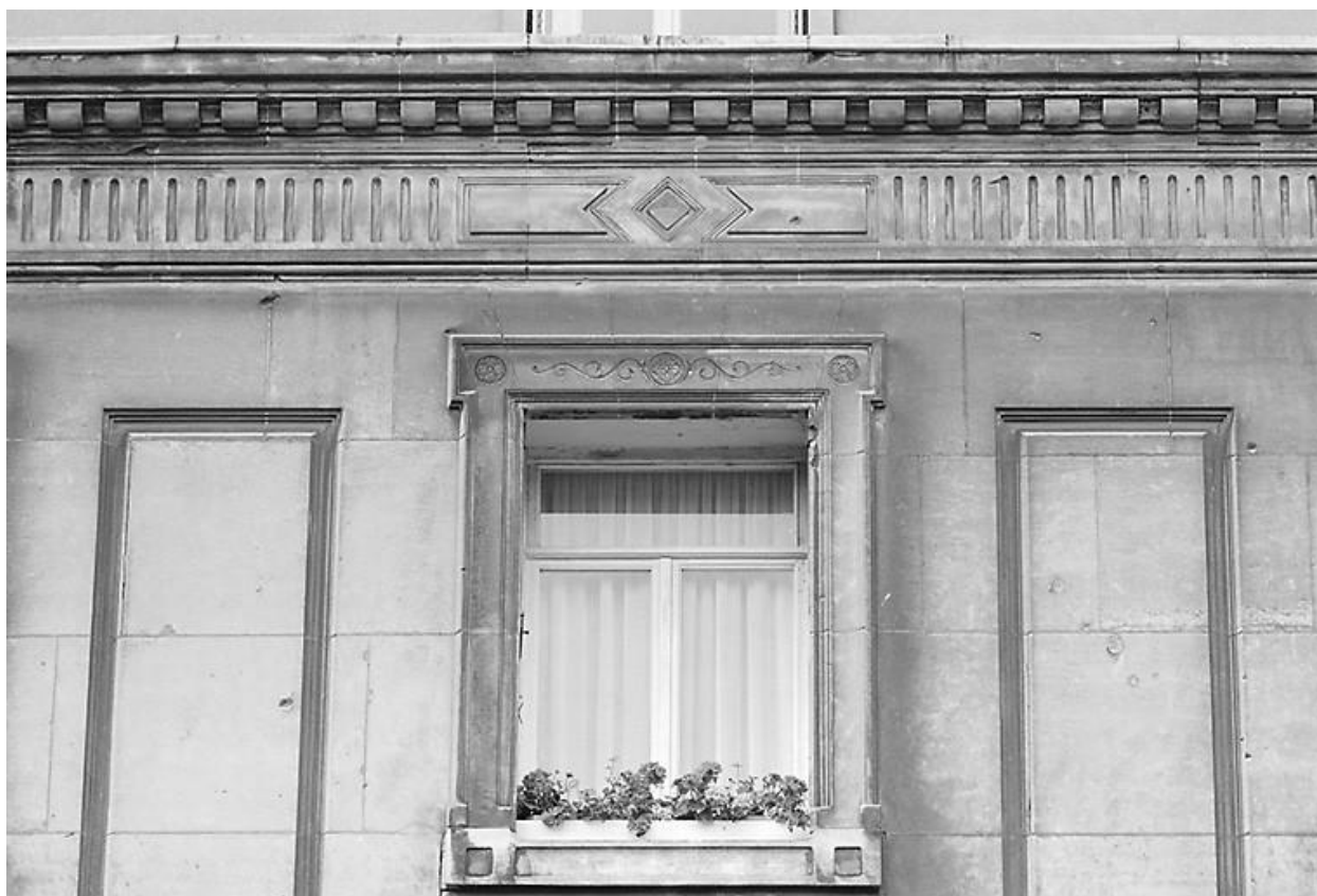
2e étage, travée centrale, fenêtre.
