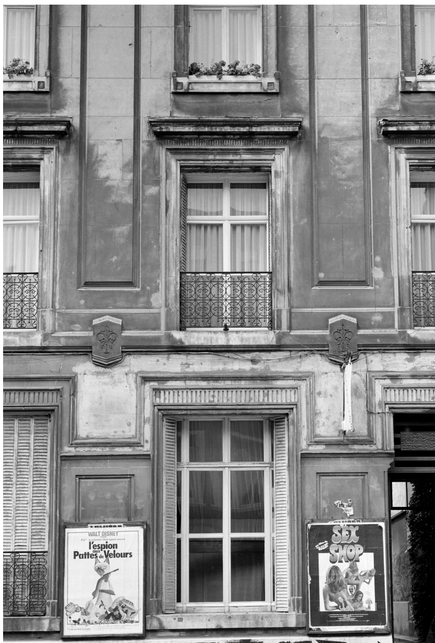
Rez-de-chaussée, 1er étage, travée centrale, fenêtres.
