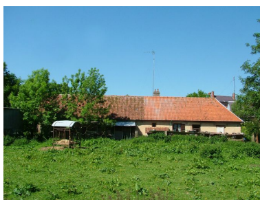
Elévation postérieure. Phot. Frédéric Fournis IVR22_20108001788NUCA
