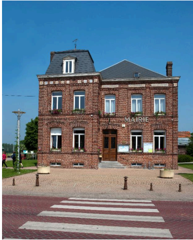
Vue générale. Phot. Pierre Thibaut IVR31_20125901780NUCA
