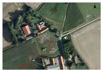
Situation des deux postes d'artillerie sur une photographie aérienne de 2009 (Géoportail, IGN) Phot. Jean-Marc Ramette IVR32_20175900328NUCA
