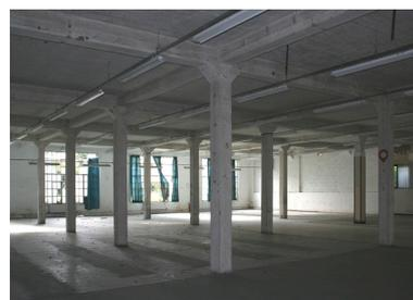
Ateliers à deux niveaux datant de la reconstruction : vue du rez-de-chaussée et de la structure poteau-poutre en béton armé.
