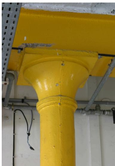
Ateliers antérieurs à 1900 (ensemble ouest) : chapiteau d'une colonne en fonte du rez-de-chaussée.
