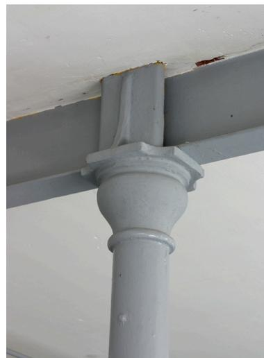
Ateliers antérieurs à 1900 (ensemble ouest) : chapiteau d'une colonne en fonte du rez-de-chaussée.
