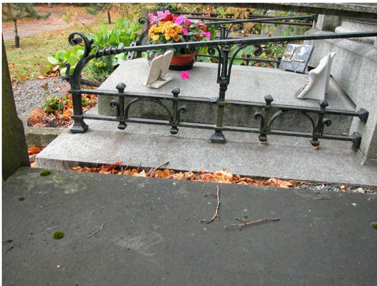
Détail de la ferronnerie.
