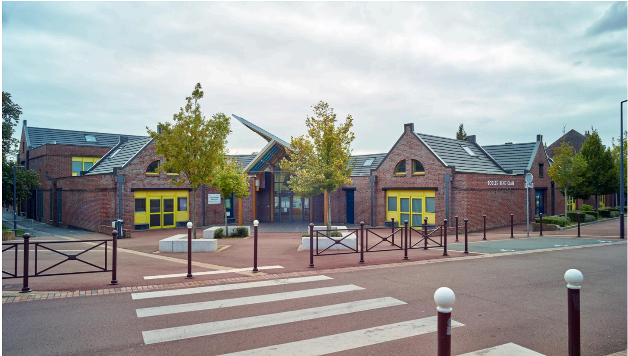
Vue du parvis et de l'entrée depuis la rue Carpeaux. À gauche le chemin des Crieurs.
