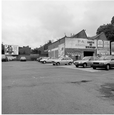
Atelier de fabrication vers l'ouest. Phot. Philippe Dapvril IVR31_19885901239X
