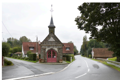
La chapelle dans son environnement direct. Phot. Delphine Volto Jourdan IVR32_20245903170NUCA
