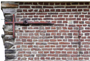
Détail des fers d'ancrage. Phot. Delphine Volto Jourdan IVR32_20245903177NUCA
