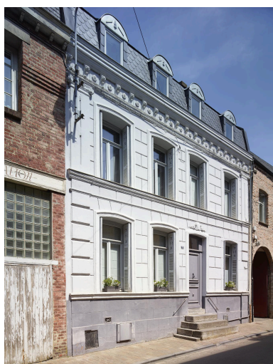
Maison de maître avec façade décorée degré - 5, rue Chevray. Phot. Pierre Thibaut IVR32_20235901041NUCA
