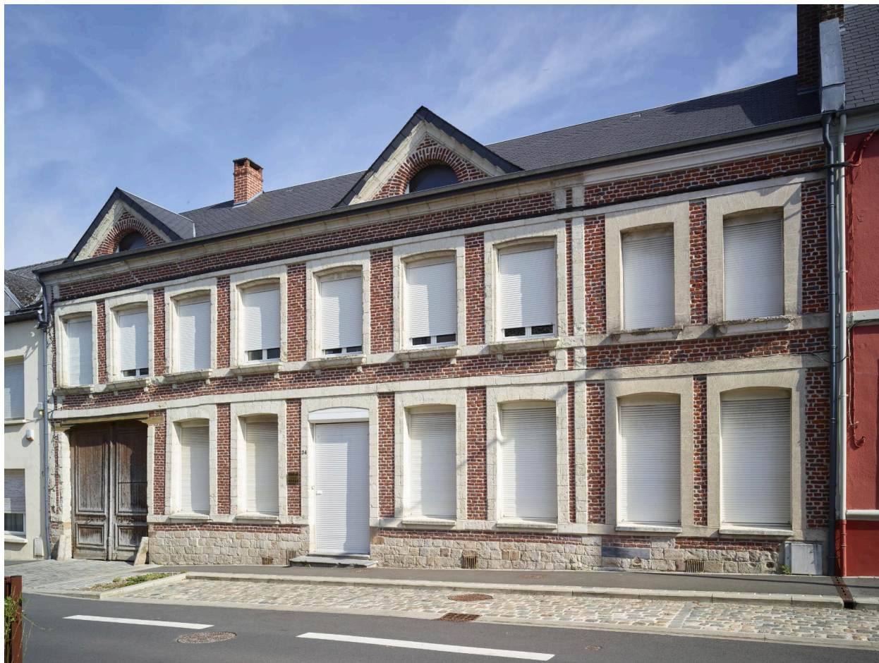
Maison de maître avec porte cochère - 34, rue Nouvelle-Zélande.
