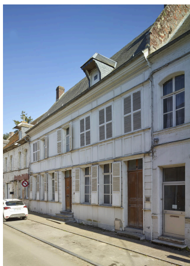
Maison de maître avec façade décorée et porte bâtarde - 10, rue Chevray. Phot. Pierre Thibaut IVR32_20255900178NUCA
