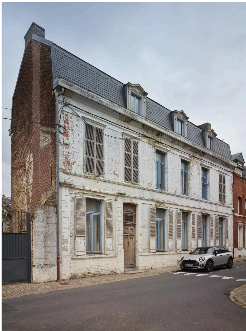
Ancienne maison de maître, puis école privée, actuellement immeuble à logement - 22, rue Baillon.
