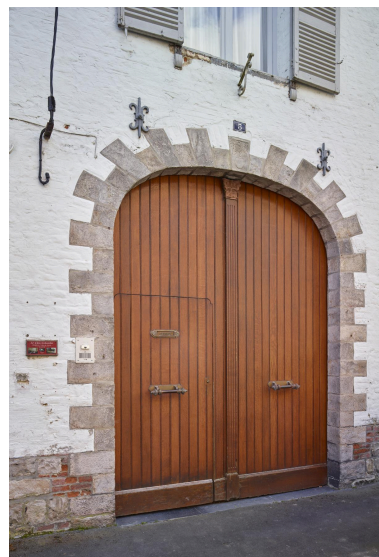
Maison de maître du XVIIe siècle avec une clef de voûte et un montant central décorés - 5, rue Brancion : détail de la porte. Phot. Pierre Thibaut IVR32_20255900147NUCA
