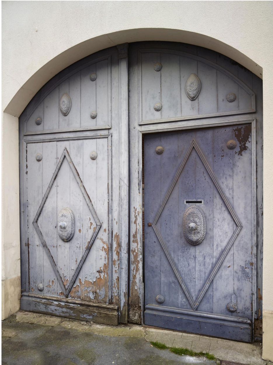
Détail de la porte cochère de l'ancienne demeure de maître - 6, rue Brancion.
