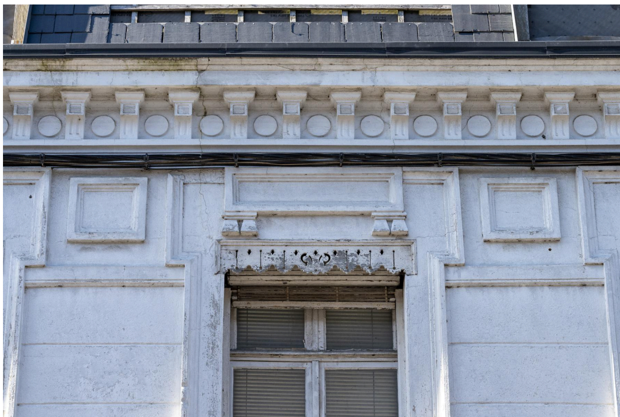
Maison de maître avec façade décorée et porte soulignée - 5, rue Victor-Hugo : détail du décor de tables affleurées et de la corniche sommitale soutenant le chéneau.
