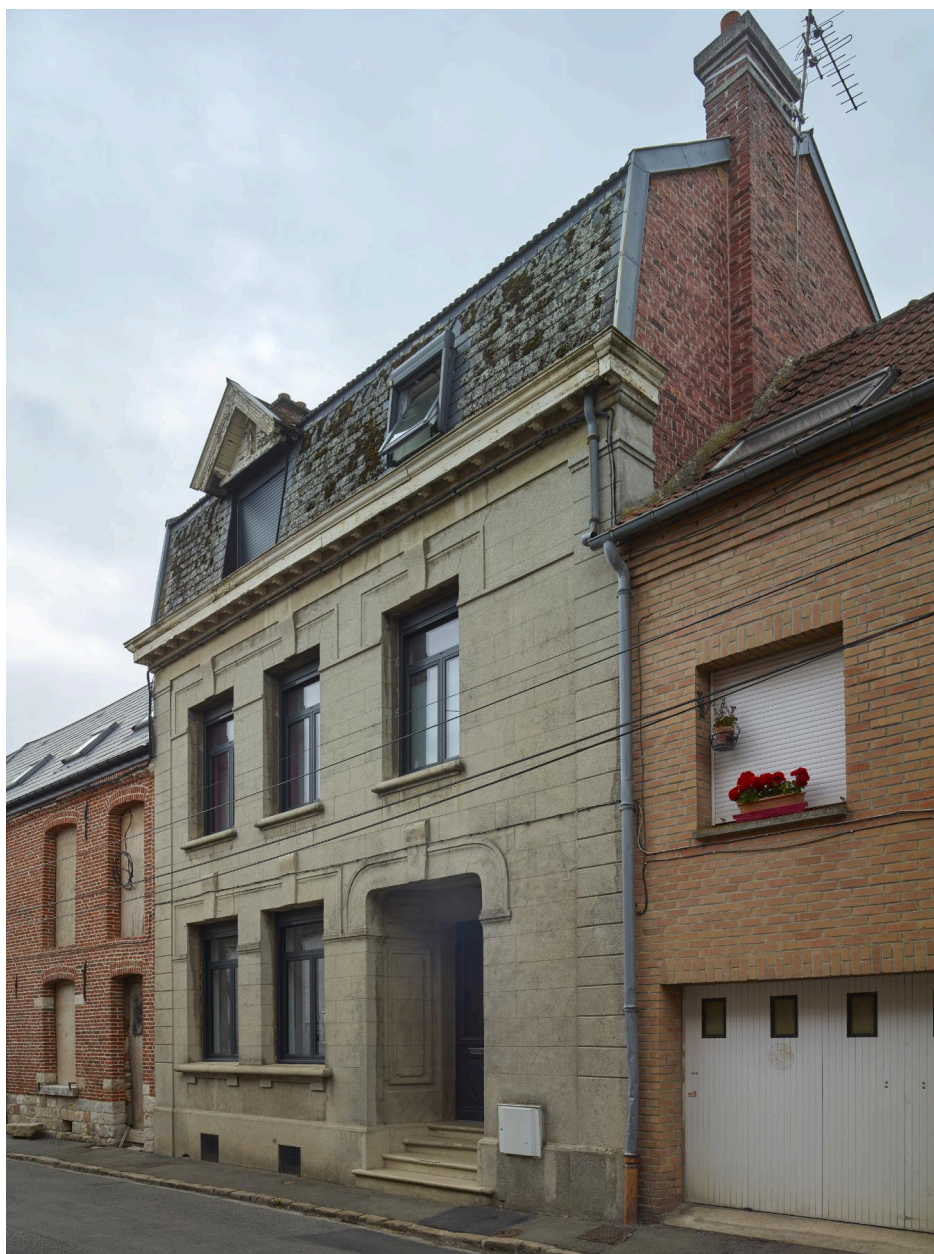
Façade principale. Vue orientée ouest/est.
