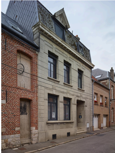
Façade principale. Vue orientée est/ouest. Phot. Pierre Thibaut IVR32_20245900169NUCA
