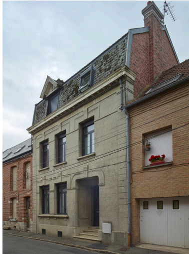
Façade principale. Vue orientée ouest/est. Phot. Pierre Thibaut IVR32_20245900170NUCA
