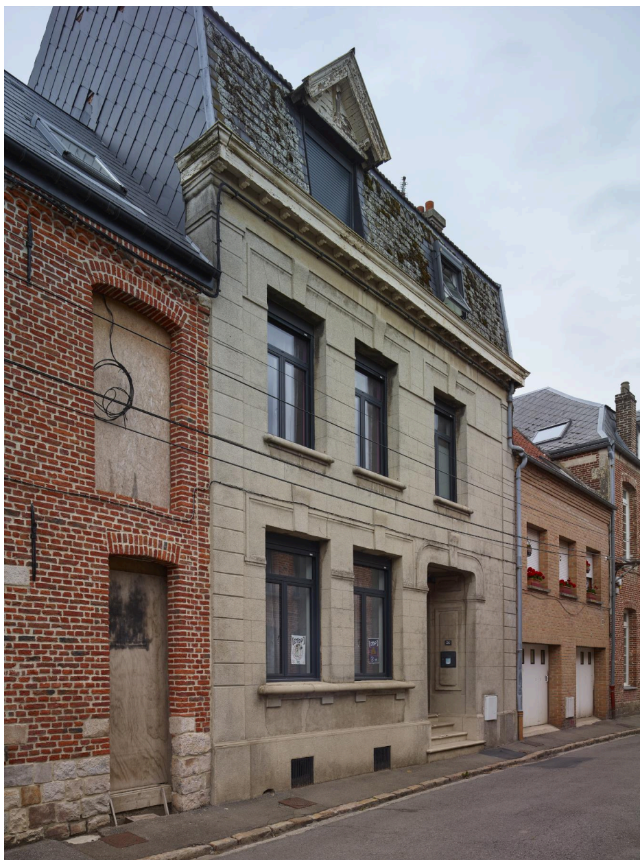
Façade principale. Vue orientée est/ouest.
