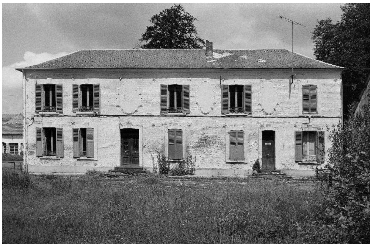
Bureaux, élévation sud.
