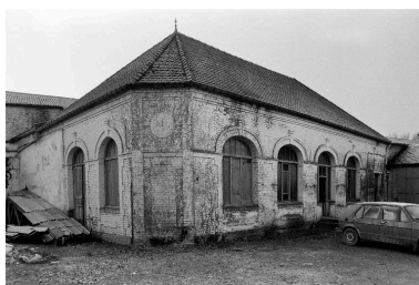
Atelier de fabrication, vue partielle, flanc nord. Phot. Benoît Dufournier IVR22_19918000356Z
