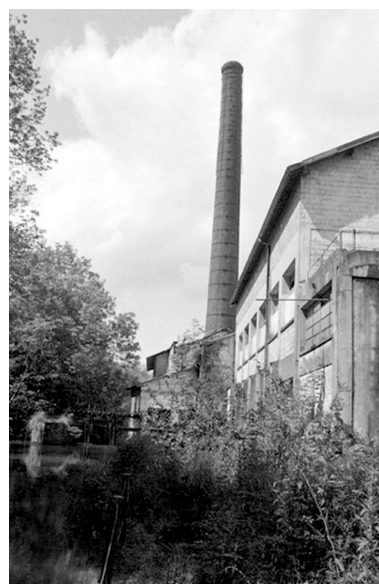
Atelier de fabrication sud, bâtiment d'eau et cheminée d'usine. Phot. Benoît Dufournier IVR22_19878000013Z
