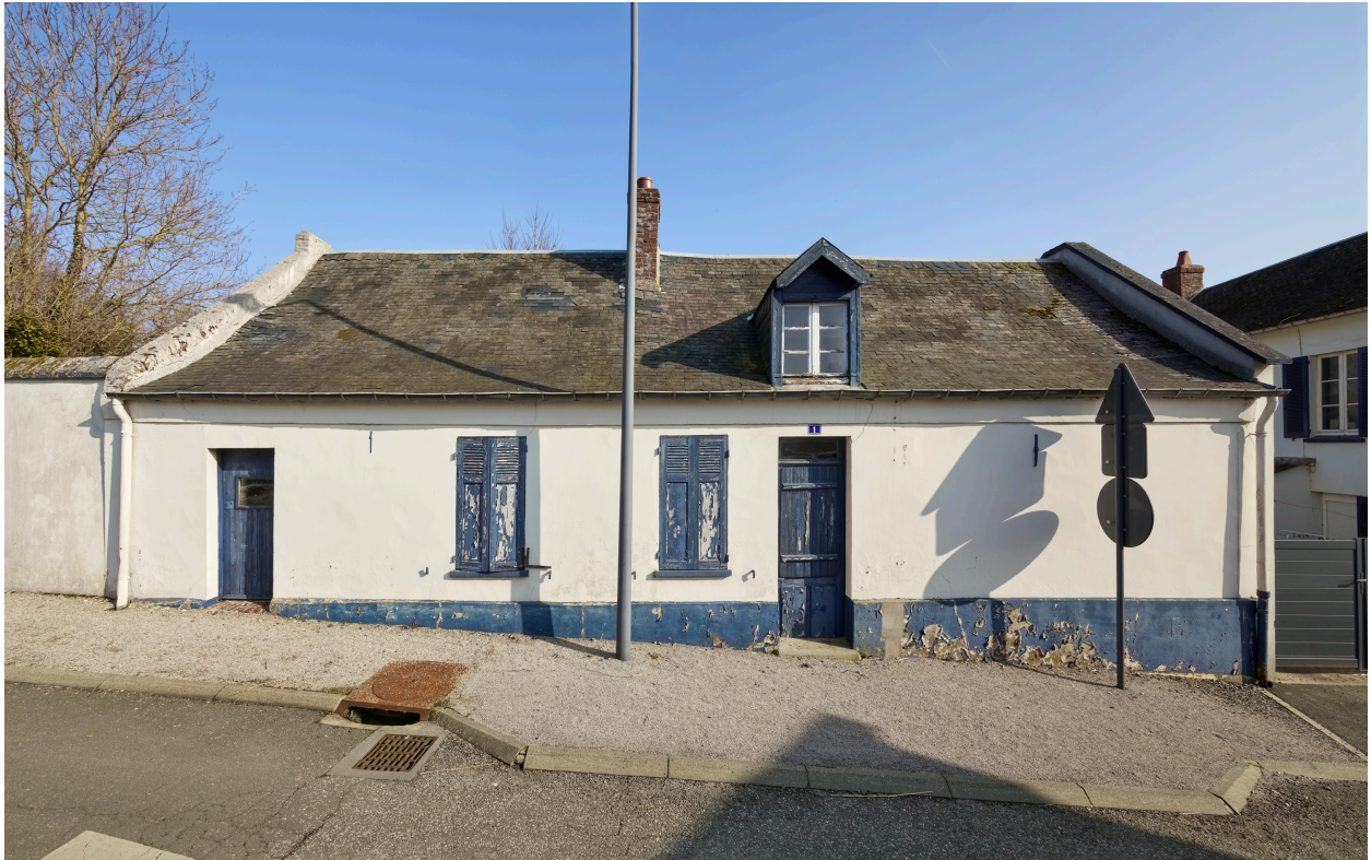
Vue de la maison depuis l'est.
