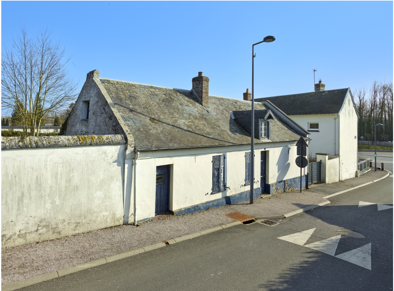
Vue de la maison depuis le nord-est.
