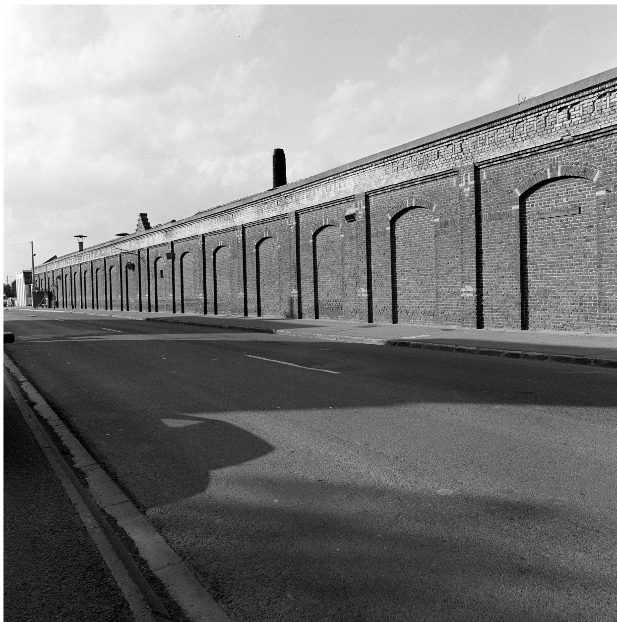
Atelier de fabrication. Élévation sur rue.
