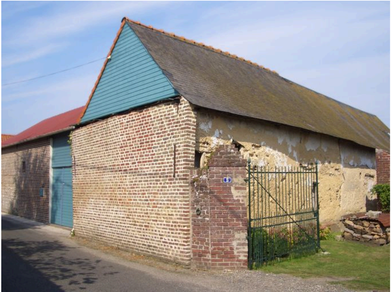
Vue de la grange.
