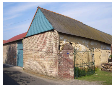
Vue de la grange. Phot. Inès Guérin IVR22_20078005235NUCA
