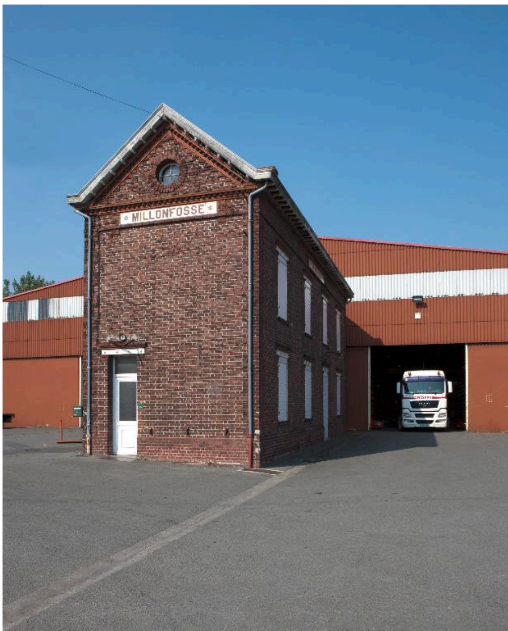
Vue de trois quarts, l'élévation postérieure.
