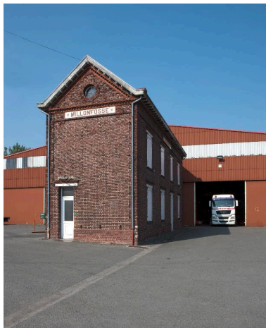
Vue de trois quarts, l'élévation postérieure. Phot. Pierre Thibaut IVR31_20125902163NUCA
