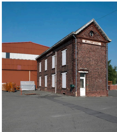
Vue de trois quarts, l'élévation antérieure. Phot. Pierre Thibaut IVR31_20125902162NUCA
