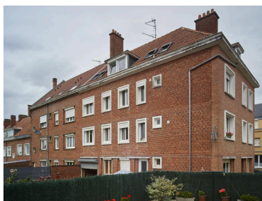
Façade arrière des n°1, 3 et 5, vue depuis la rue Carlier. Vue orientée sud-ouest/nord-est. Phot. Pierre Thibaut IVR32_20245900160NUCA
