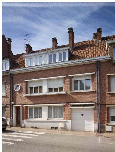
Détail du n°7, maison individuelle. Phot. Pierre Thibaut IVR32_20245900873NUCA
