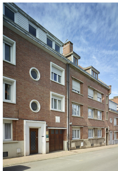
Détail des n°1, 3 et 5 montrant la différence de gabarit entre les immeubles à logements et la maison jointive, mais également la continuité formelle entre les deux bâtiments. Vue orientée sud/nord. Phot. Pierre Thibaut IVR32_20245900880NUCA
