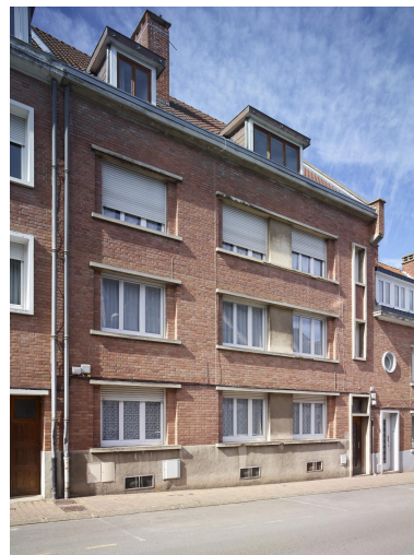
Détail de l'immeuble à logements, n°3. Phot. Pierre Thibaut IVR32_20245900875NUCA
