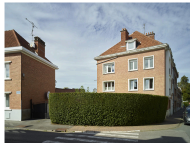
Façade pignon sur la rue Carlier. Phot. Pierre Thibaut IVR32_20245900912NUCA
