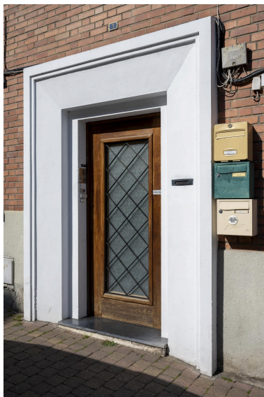
Détail de la porte du n°1 (immeuble collectif) : du décor en fer forgé en quadrillage de petits carrés et large entourage en béton avec chambranle à cru mouluré. Phot. Pierre Thibaut IVR32_20255900499NUCA
