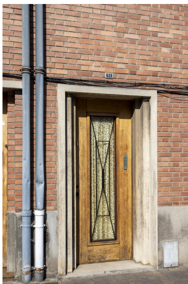
Détail du décor en fer forgé protégeant la porte du n°11 : croix de Saint-André brochant sur deux rectangles emboîtés. Phot. Pierre Thibaut IVR32_20255900505NUCA
