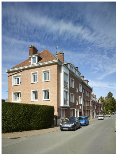
Vue générale du rang. Vue orientée sud/nord. Phot. Pierre Thibaut IVR32_20245900878NUCA
