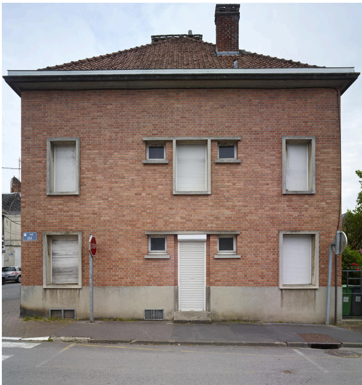
Façade pignon sur la rue Goa.
