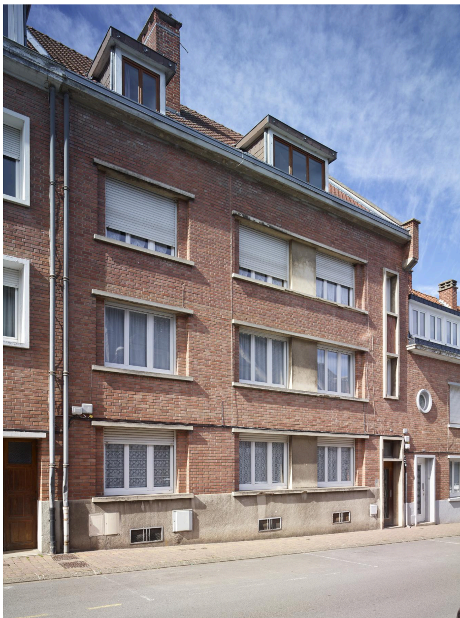
Détail de l'immeuble à logements, n°3.
