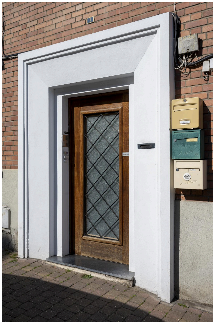
Détail de la porte du n°1 (immeuble collectif) : du décor en fer forgé en quadrillage de petits carrés et large entourage en béton avec chambranle à cru mouluré.
