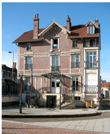
Façade de l'ancienne brasserie Gryson (Montataire). Phot. Clarisse Lorieux IVR22_20076005549NUCA
