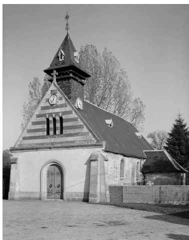
Vue générale. Phot. Jean-Michel Périn IVR22_19846001325V
