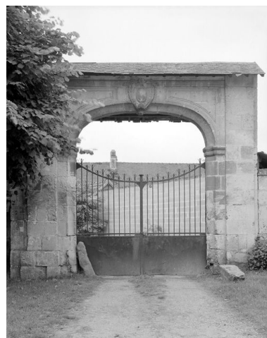
Portail du prieuré. Phot. Jean-Michel Périn IVR22_19856000996V
