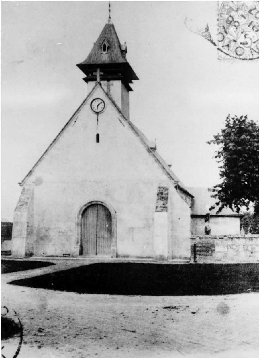
Façade ouest. Etat avant 1914 (coll. part.)
