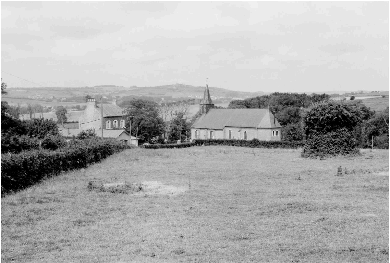
Vue générale de l'église dans son environnement.
