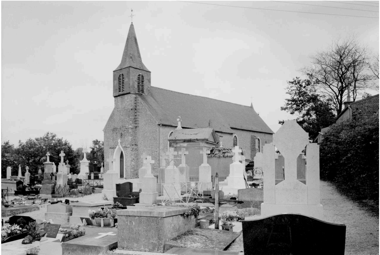
Vue générale du cimetière.
