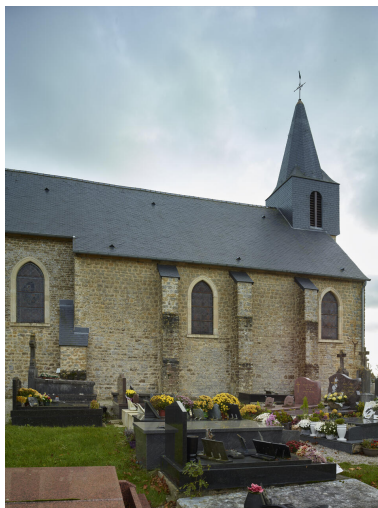
Vue de l'élévation nord. Phot. Pierre Thibaut IVR32_20236200985NUCA
