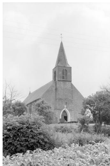
Vue générale nord-ouest. Phot. Jean-Michel Périn IVR31_19806203586X
