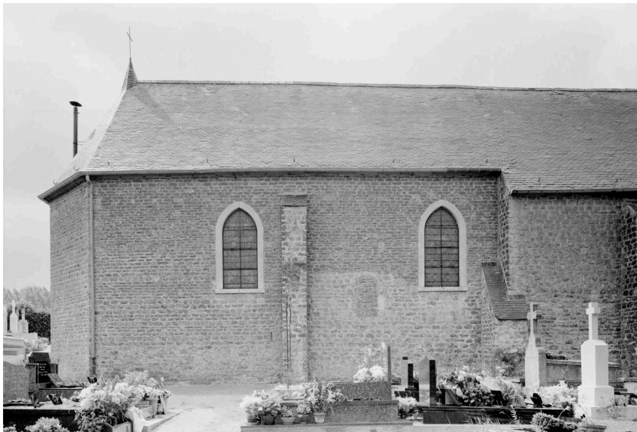
Façade nord (chœur).
