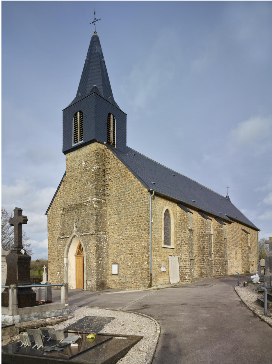
Vue générale depuis le sud-ouest.
