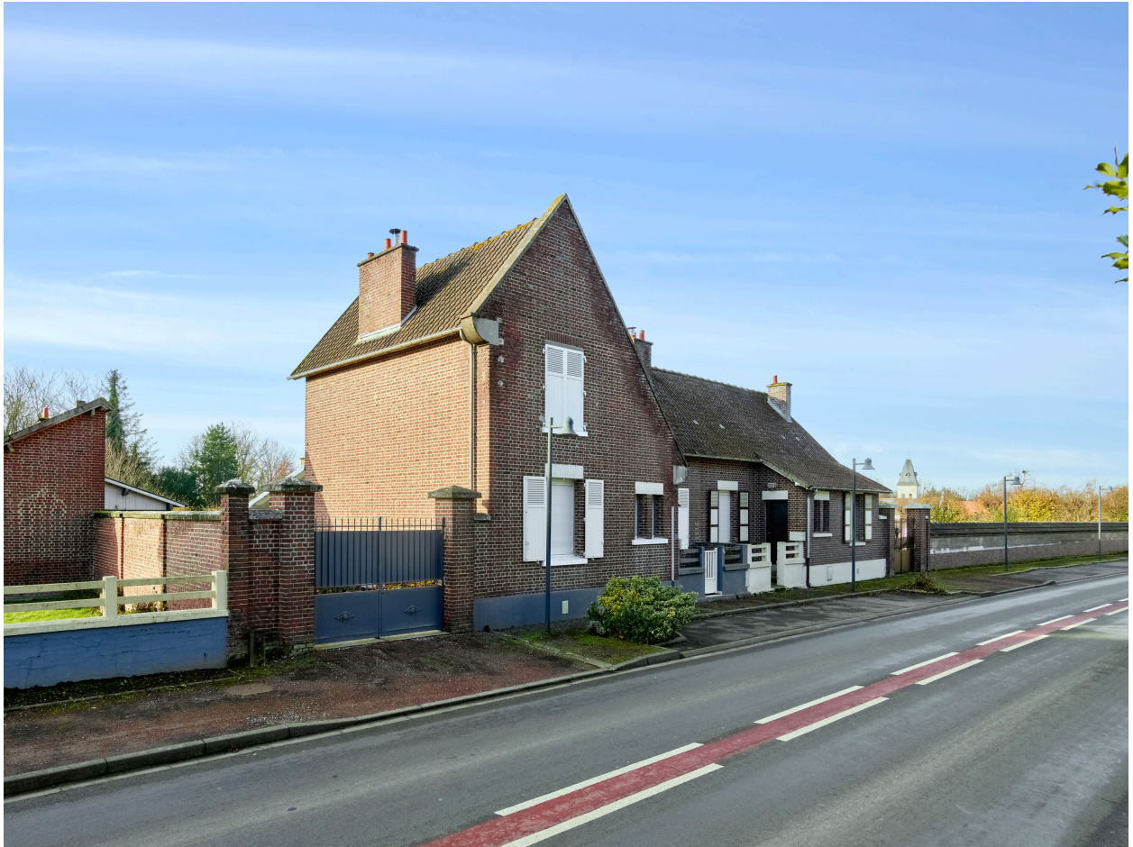
Vue de la maison, depuis le nord/est.
