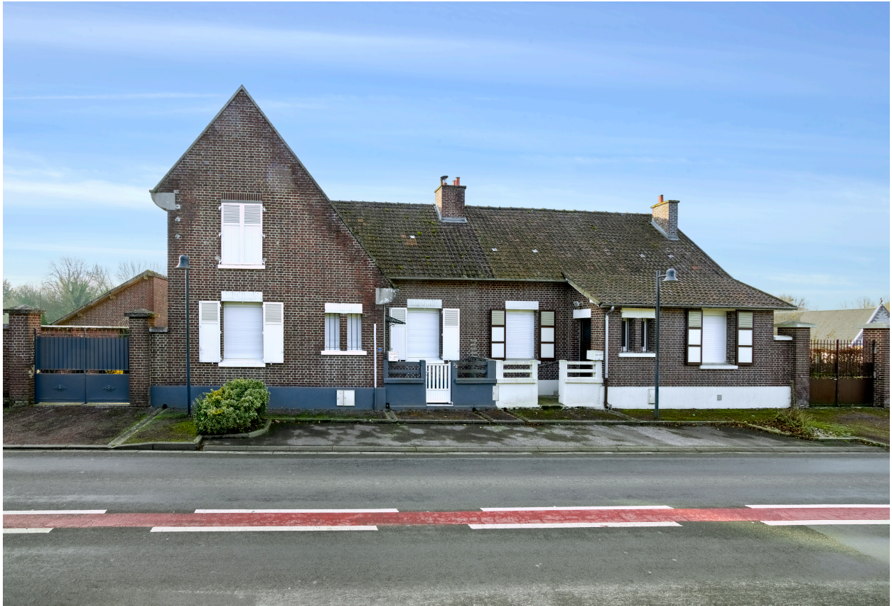
Vue de la maison, depuis le nord.
