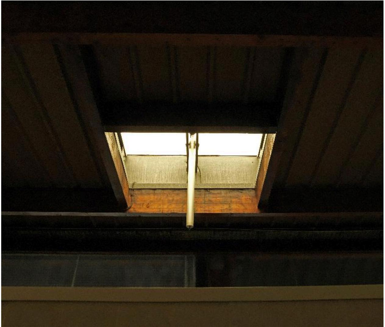
Détail d'un des velux, ouvertures pratiquées dans la toiture pour permettre l'éclairage zénithal des bassins et des vestiaires.
