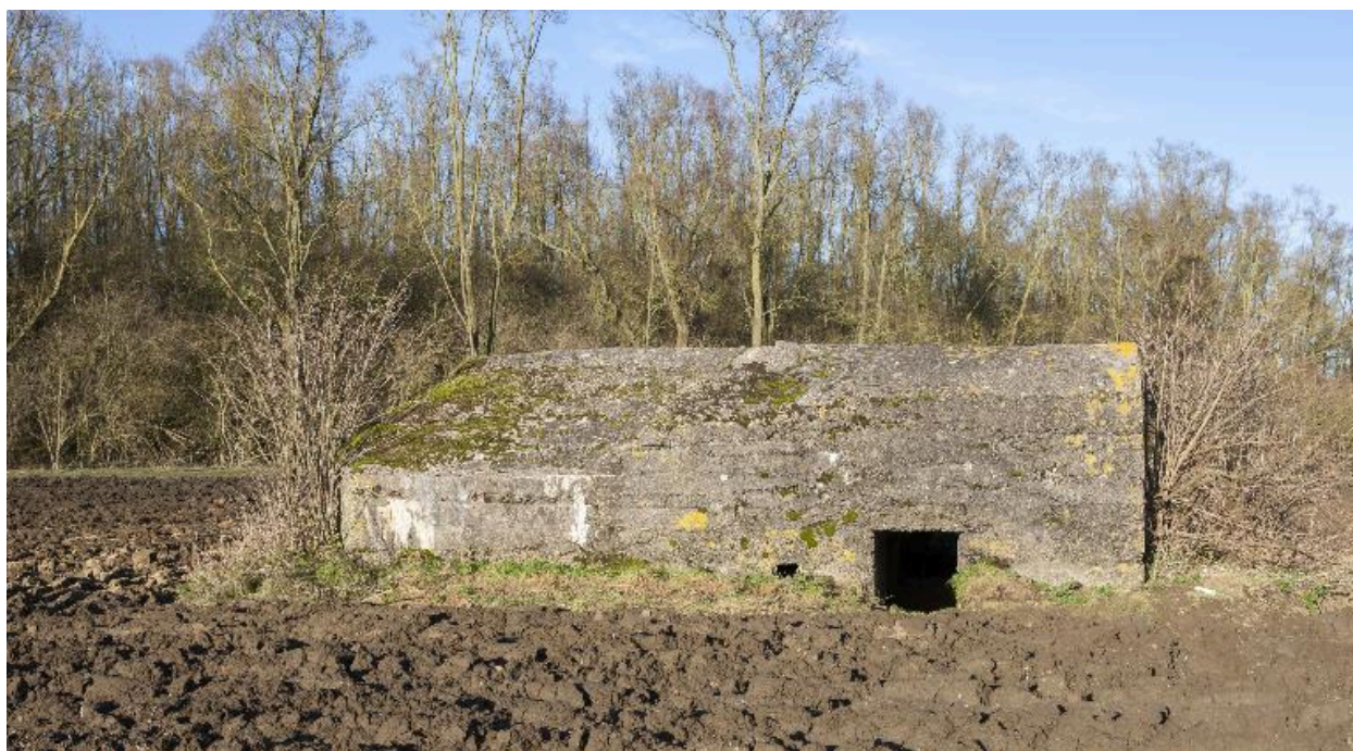
Vue latérale vers le nord-est
