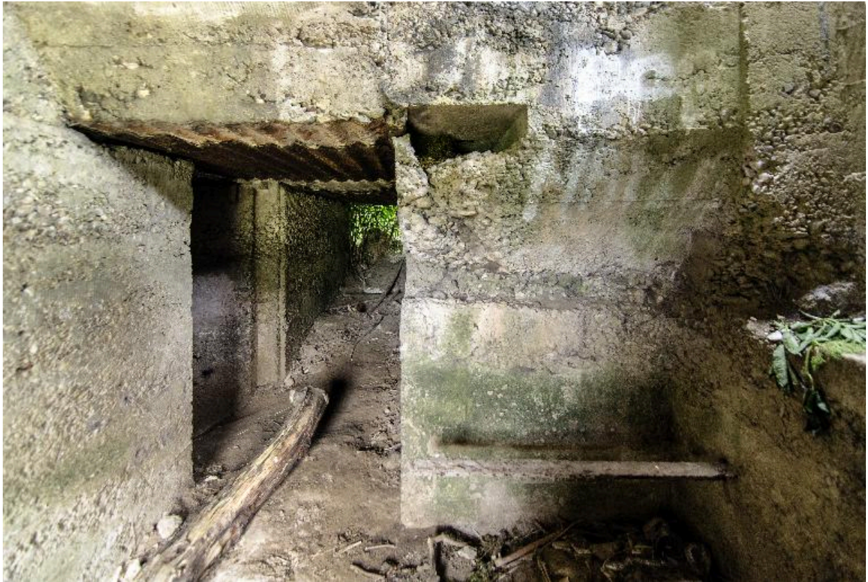
Depuis l'entrée, le couloir de distribution avec, à droite, le poste d'observation (au grand angulaire)
