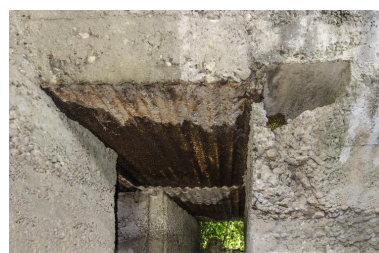
Couloir de distribution, détail du plaquage en tôle ondulée (au grand angulaire) Phot. Jean-Marc Ramette IVR32_20165901153NUCA
