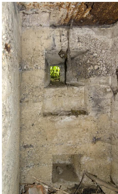
Créneau de fusillade vers le nord-est Phot. Jean-Marc Ramette IVR32_20165901160NUCA
