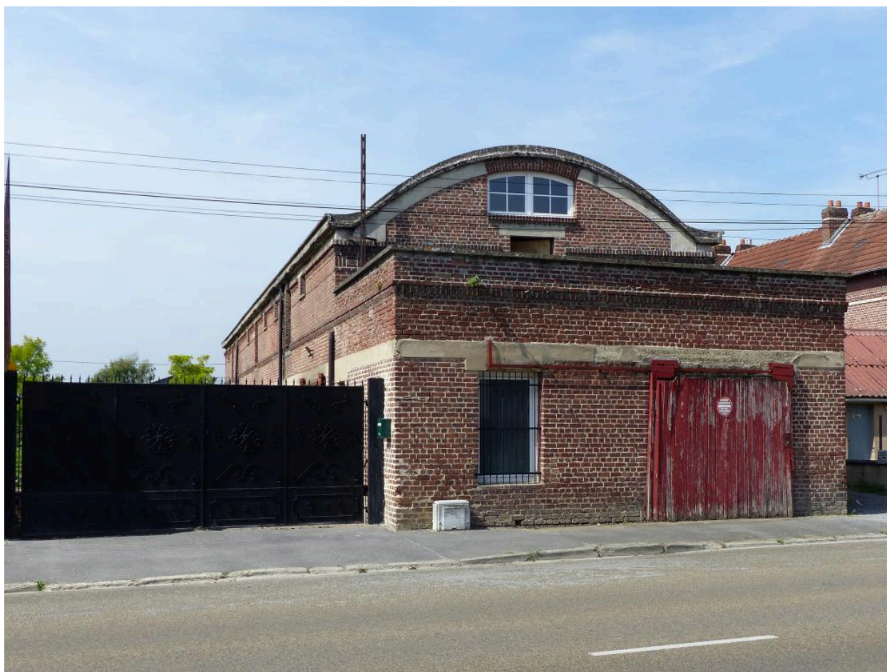
Vue de l'étable au nord de la cour.
