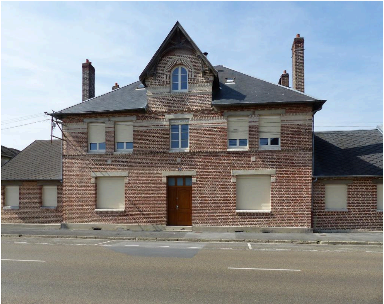
Vue du logis sur rue.
