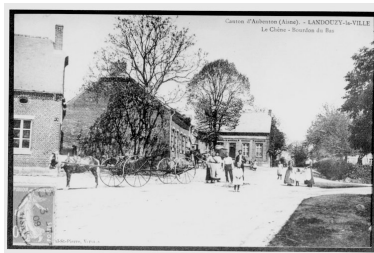
Vue des fermes à l'entrée du hameau du Chêne-Bourdon-de-Bas, depuis le carrefour (AP). Phot. Brest Pierre-Yves IVR22_19980202488ZB
