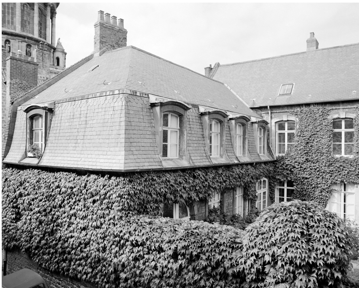
Façade partielle sur cour, façade est, vue plongeante.
