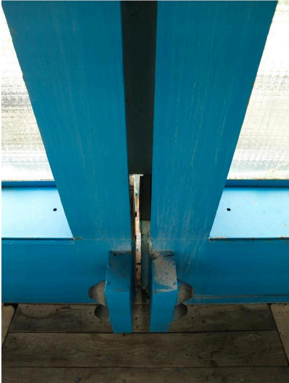
Détail de la jointure entre les deux parties de la structure mobile.
