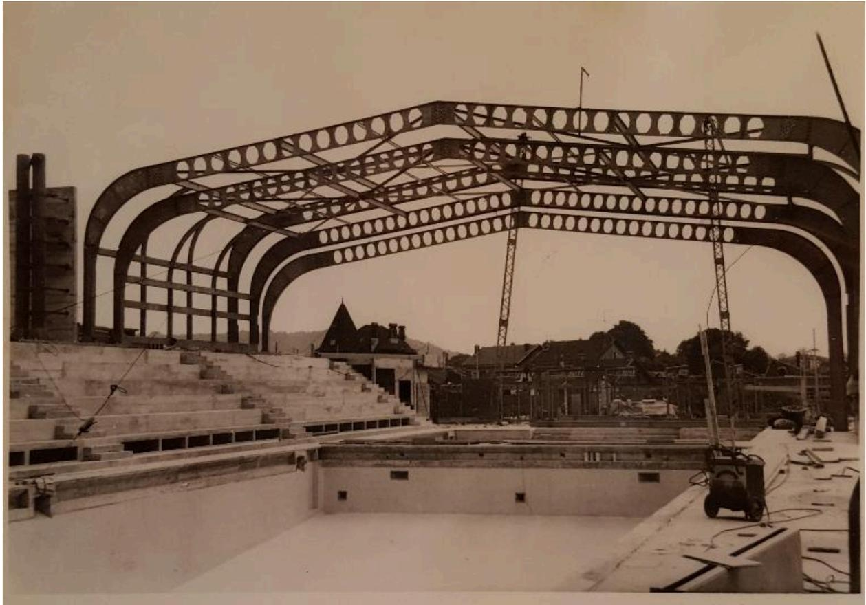
Photo de la piscine en construction, groupe des trois éléments (1 fixe et 2 mobiles) côté Est, juin 1967. Photo : Société MacGregor-Comarain (AN ; 19940528/1).
