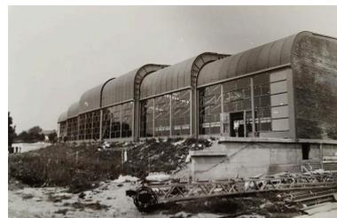
Photo de la piscine en construction, groupe des 3 éléments (1 fixe et 2 mobiles) côté Ouest, en position d'ouverture, juin 1967. Photo : Société MacGregor-Comarain (AN ; 19940528/1).
