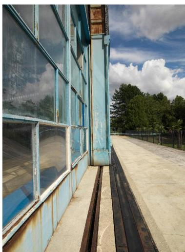
Détail de la structure mobile et des rails permettant aux éléments de glisser et de s'emboîter les uns au dessus des autres.
