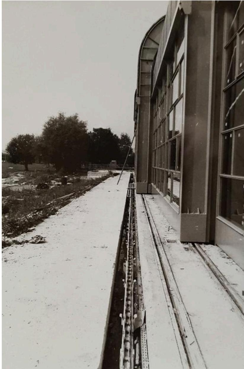
Vue des rails permettant aux éléments mobiles de s'ouvrir. Vue de chantier, juillet 1967. Photo : Société MacGregor-Comarain (AN ; 19840036/145).
