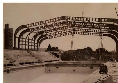
Photo de la piscine en construction, groupe des trois éléments (1 fixe et 2 mobiles) côté Est, juin 1967.
