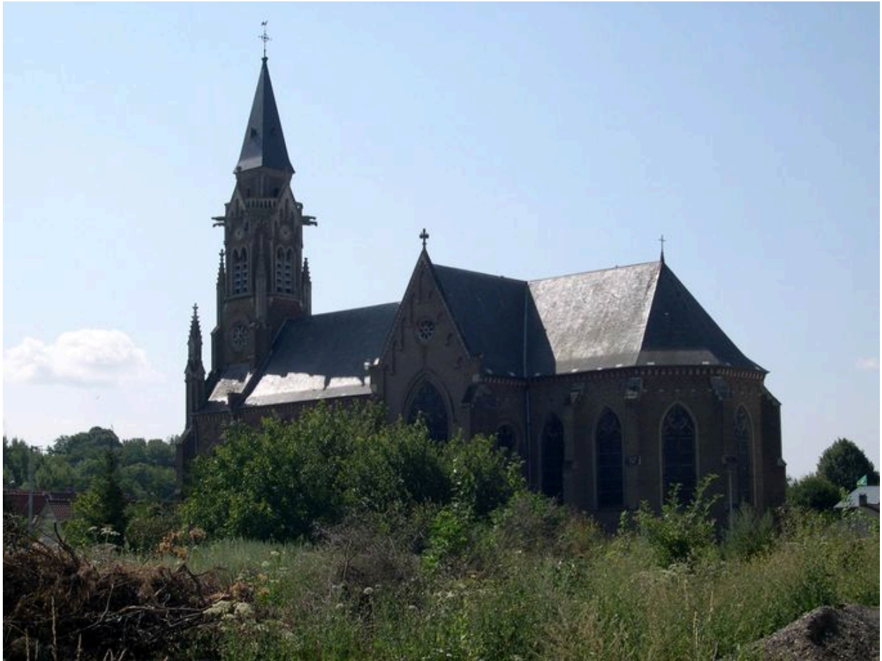
Vue de situation depuis le nord-ouest.
