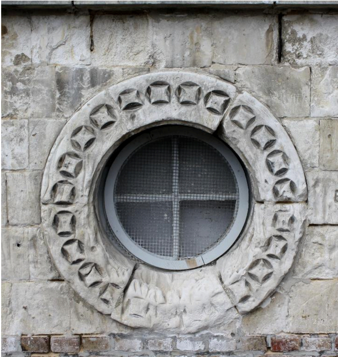
Logement de l'ancienne école de garçons. Façade sur cour, détail d'un oculus du soubassement.
