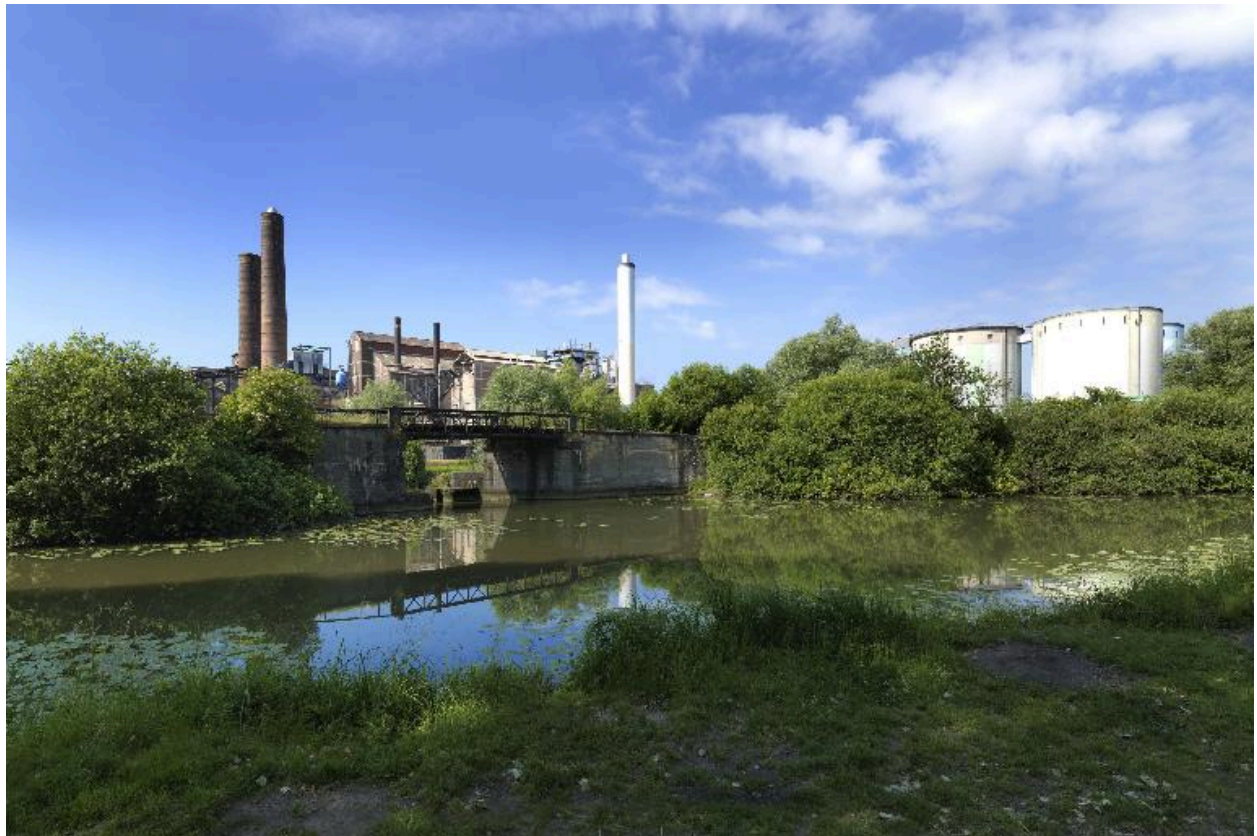
Vue d'ensemble de la sucrerie depuis le chemin de halage du canal.
