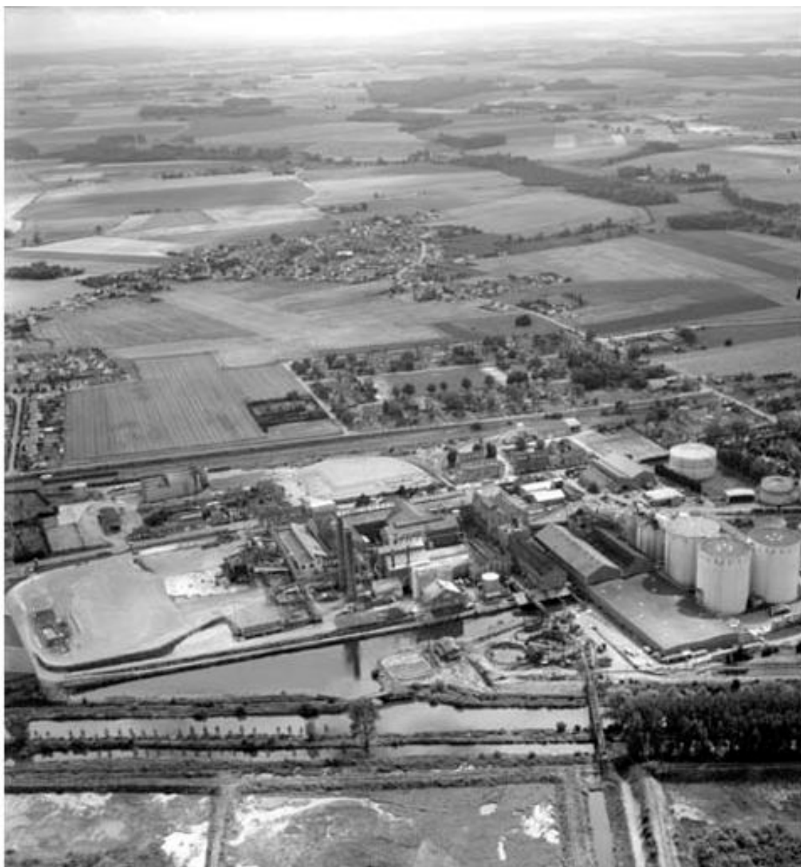
Vue aérienne flanc est de l'usine.
