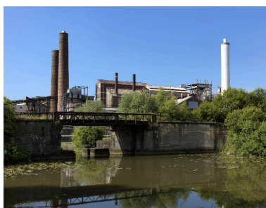
Vue d'ensemble de la sucrerie depuis le chemin de halage. Phot. Thierry Lefébure IVR22_20158000516NUC2A
