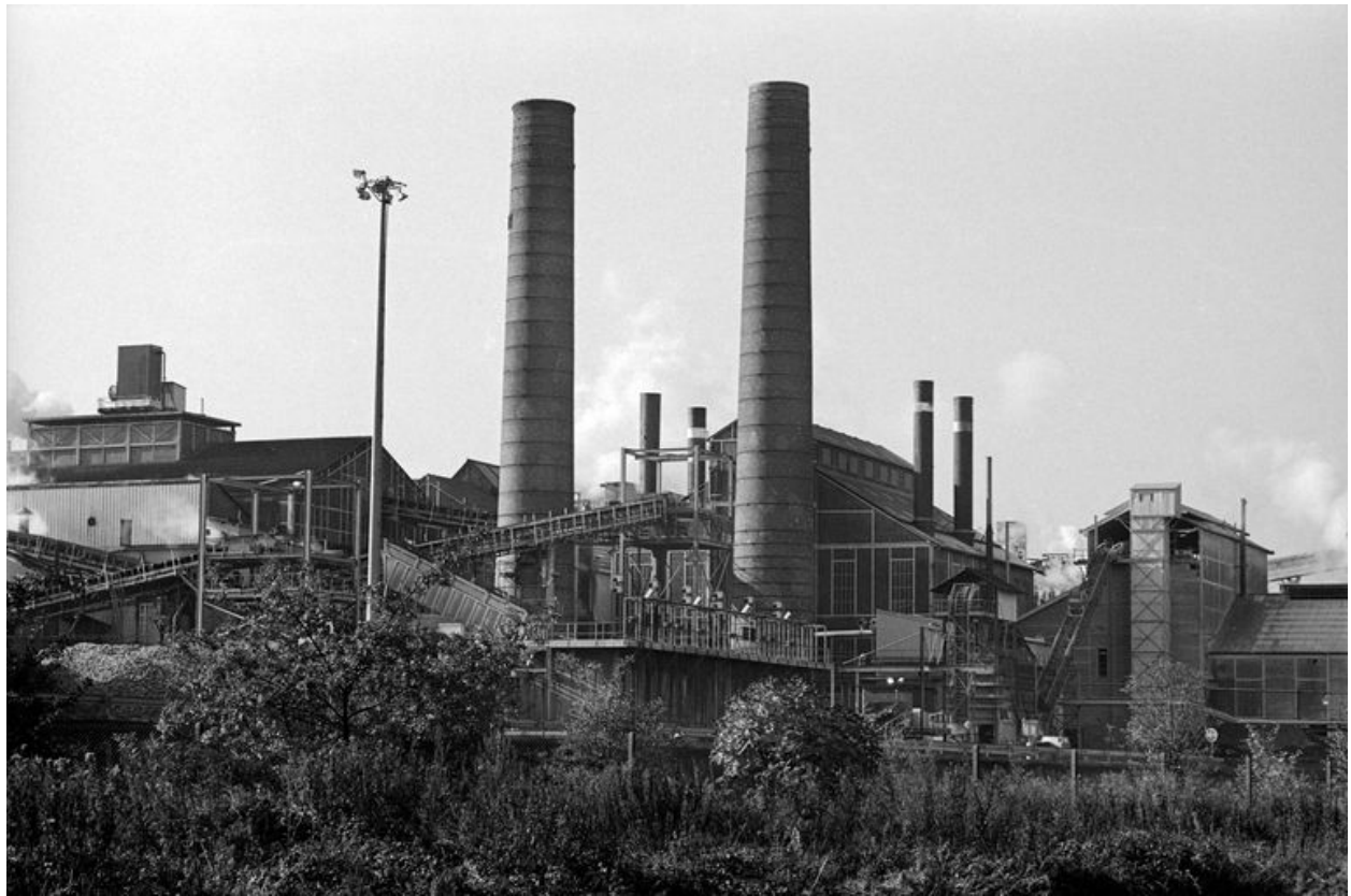
Vue partielle, flanc est.
