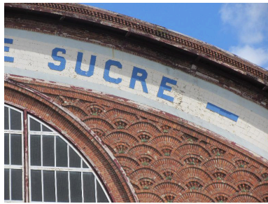
Détail du fronton de l'atelier principal de la sucrerie. Phot. Bertrand Fournier IVR22_20158006138NUCA
