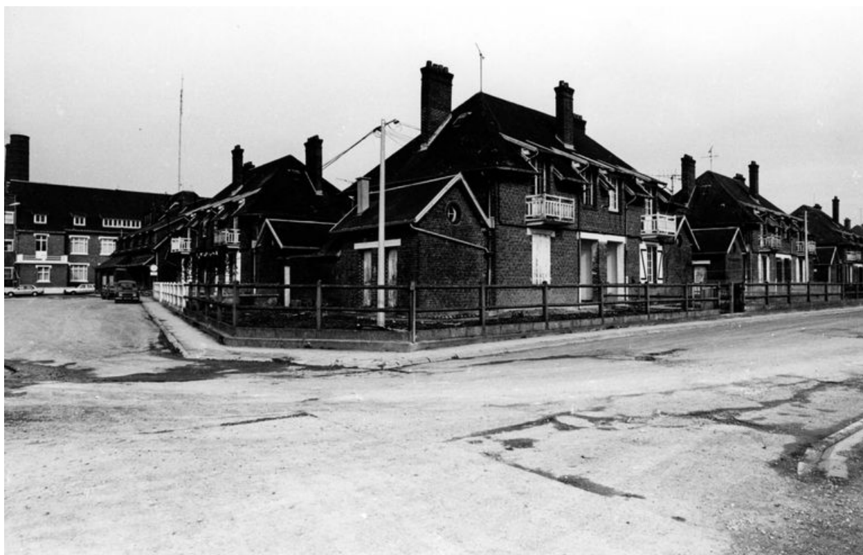
Logements d'ouvriers, en 1983 (Ecomusée du Beauvaisis).
