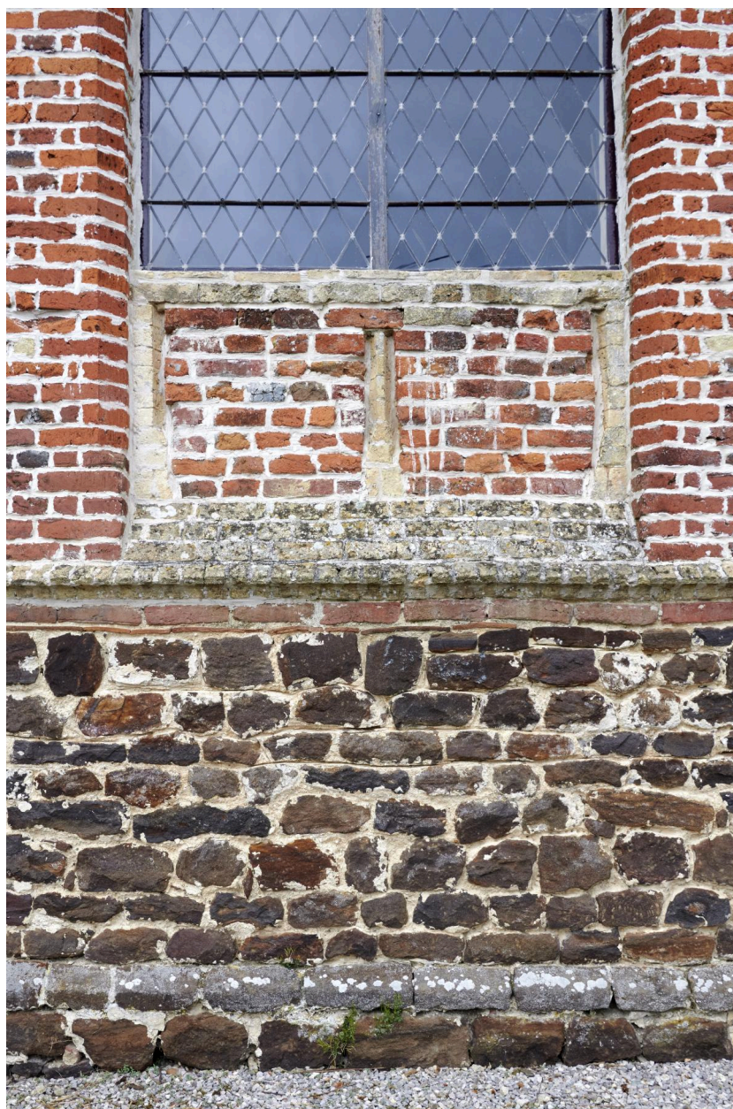
Détail des matériaux composites de l'élévation sud. Présence d'un vestige de meneau en brique jaune dans la base de l'actuelle baie.
