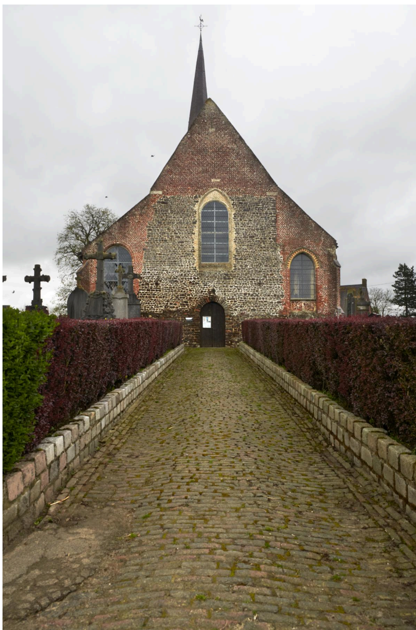
Allée pavée et façade occidentale de l'église.
