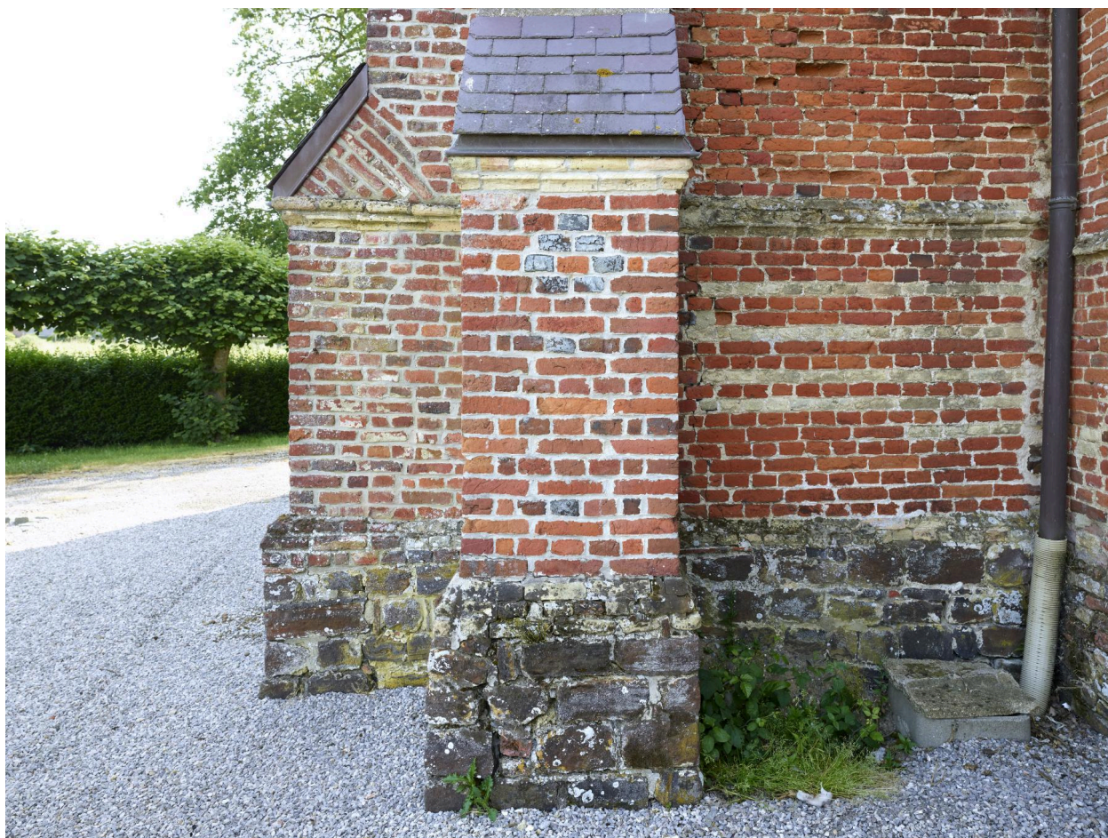
Détail d'un contrefort nord, avec symboles géométriques en briques surcuites noires.
