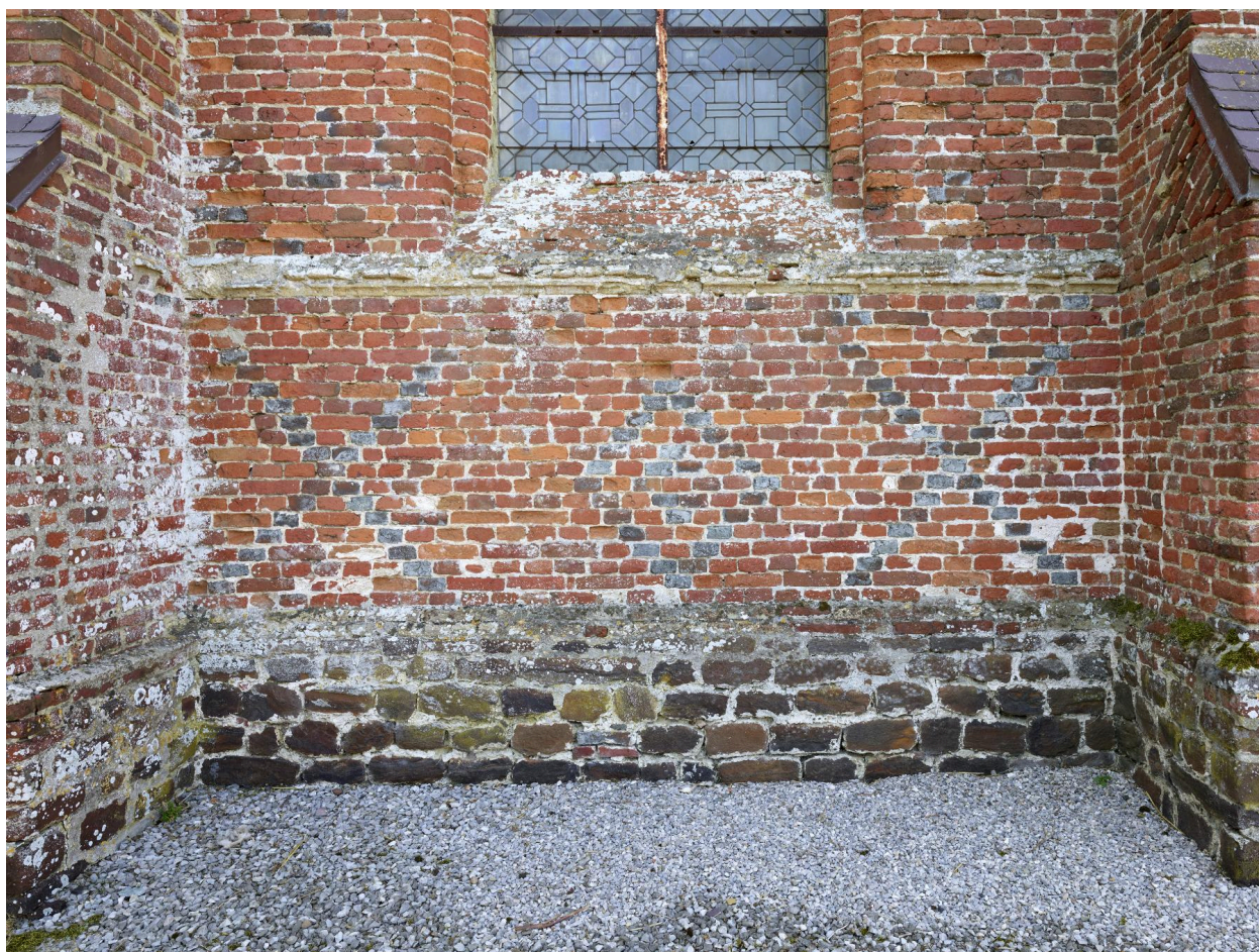
Détail des symboles géométriques en brique et des matériaux de l'élévation.
