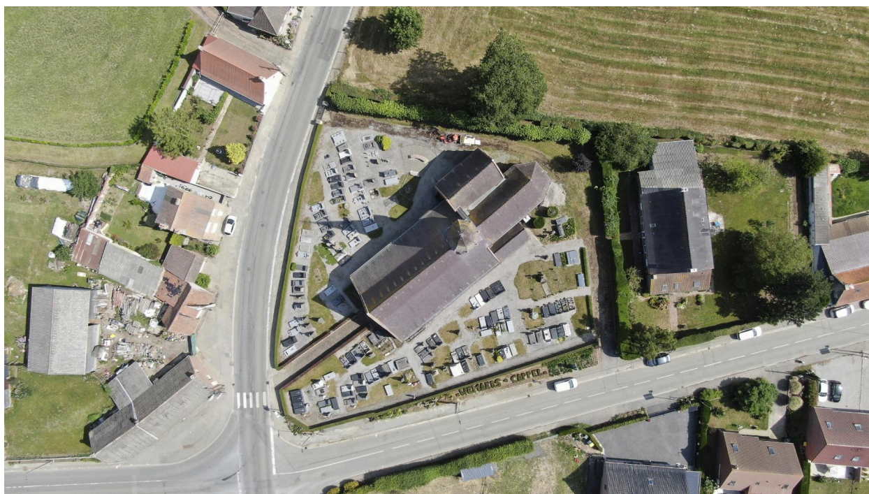
Vue zénithale de l'église.
