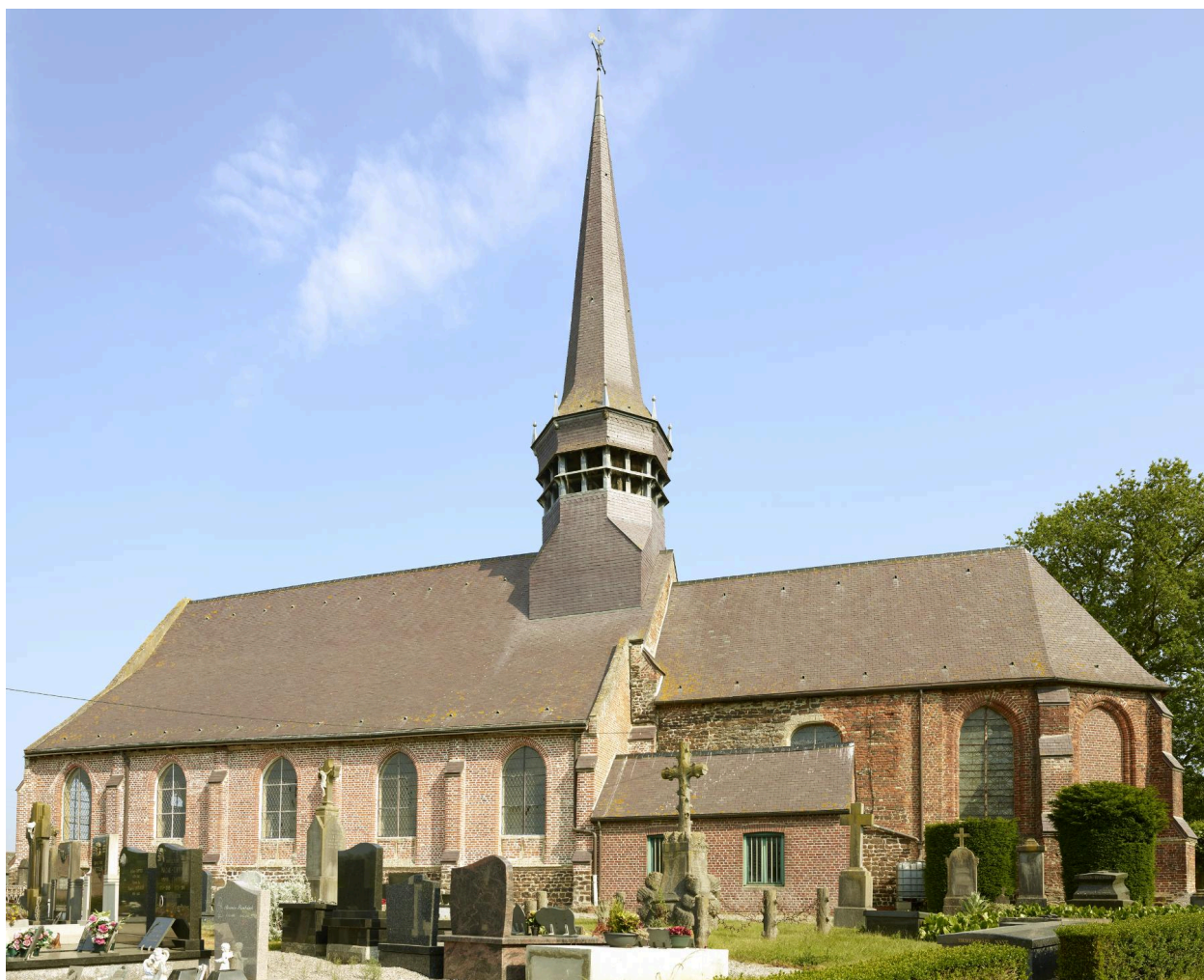
Vue générale de l'église depuis le sud.
