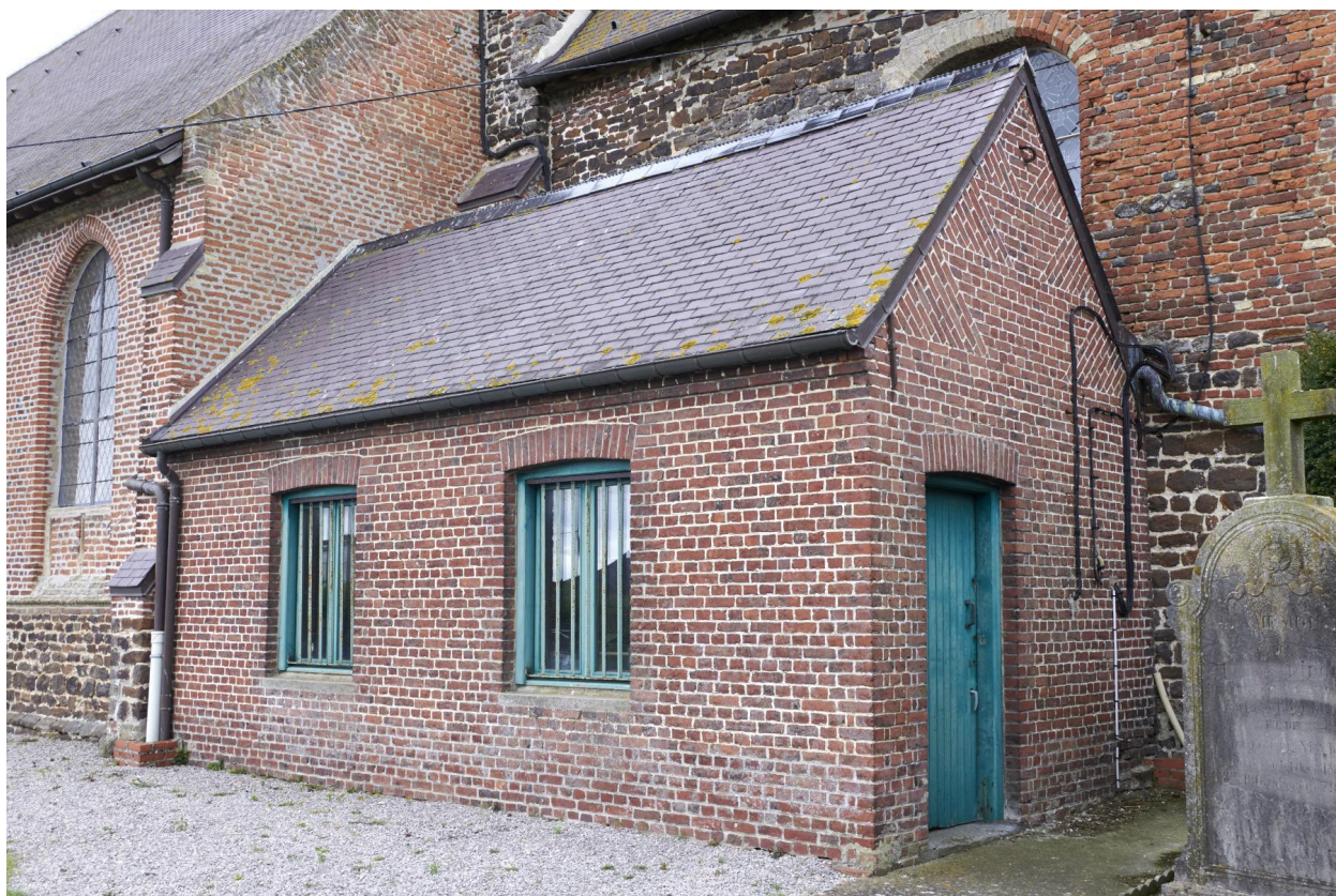
Sacristie implantée au sud-est de l'église. XXe siècle.
