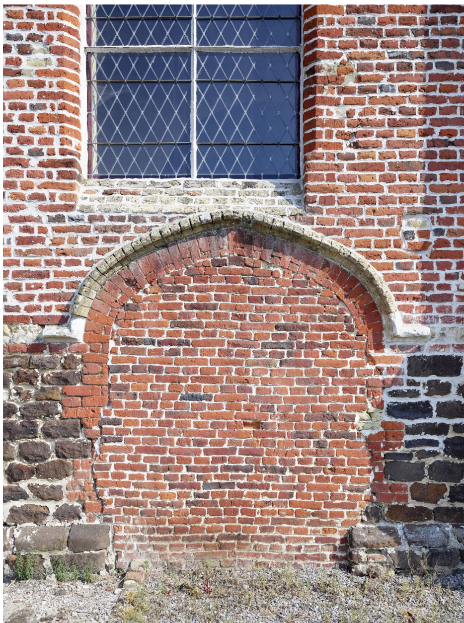
Ouverture XVIe s. rebouchée (dite porte du Paradis). Localisée sur le bas-côté sud, voutée en arc brisé aplati.
