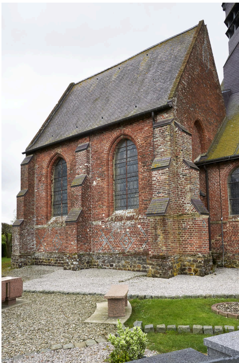
Vue de la chapelle seigneuriale au nord-ouest de l'église.
