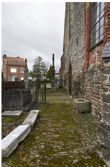
Allée pavée le long de la façade occidentale de l'église. Phot. Delphine Volto-Jourdan IVR32_20245901652NUCA
