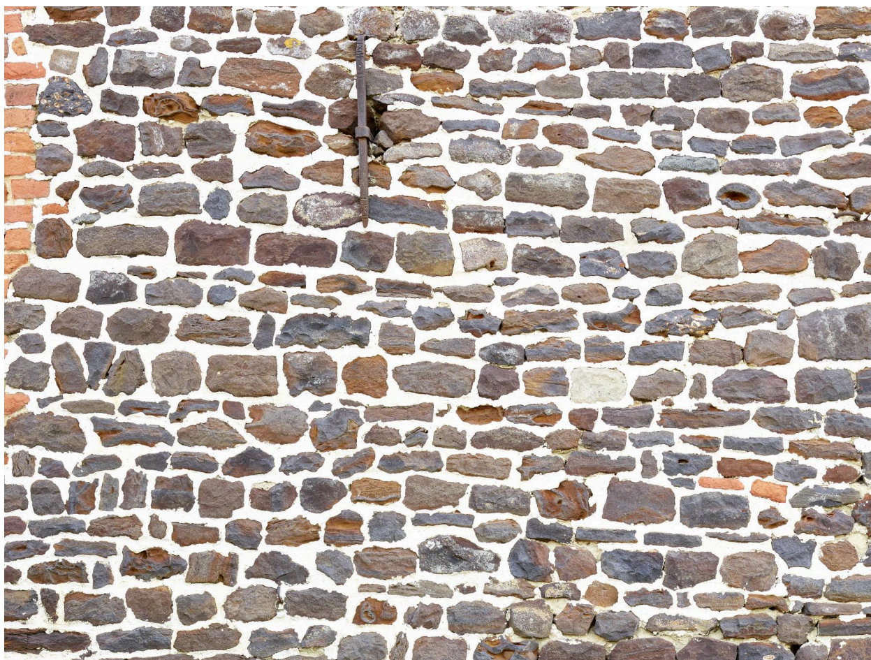
Détail de l'une des élévations originelles en grès de Cassel.
