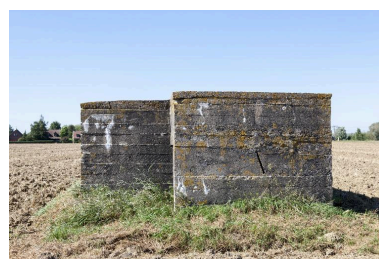
Vue latérale vers le nord-ouest Phot. Pierre Thibaut IVR32_20165901371NUCA
