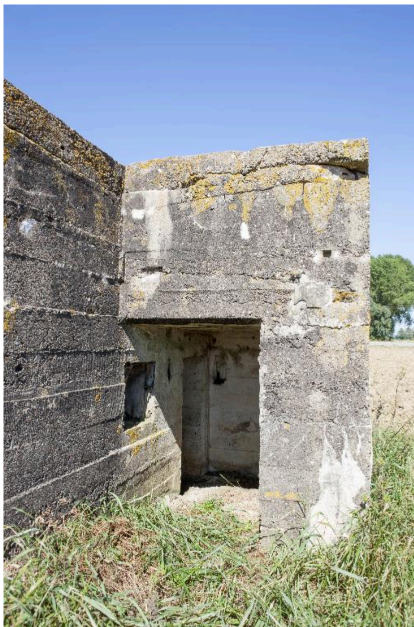
Vue vers le nord. Entrée pare-souffle
