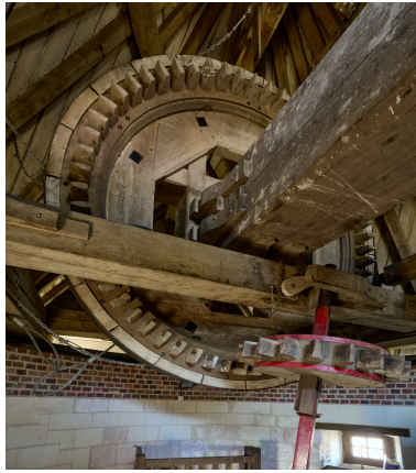
Intérieur, mécanisme du moulin, deuxième étage. Phot. Thierry Lefébure IVR32_20248001743NUCA
