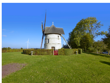
Vue du moulin, depuis le sud. Phot. Thierry Lefébure IVR32_20248001730NUCA
