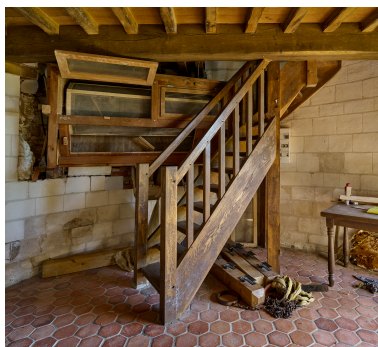
Intérieur, rez-de-chaussée du moulin. Phot. Thierry Lefébure IVR32_20248001753NUCA
