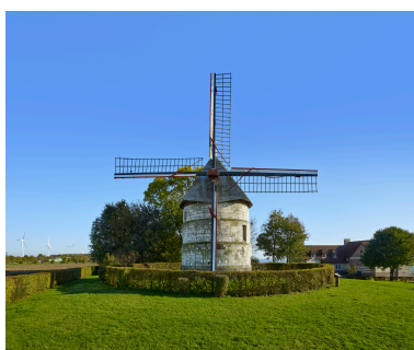
Vue du moulin, depuis l'ouest. Phot. Thierry Lefébure IVR32_20248001740NUCA
