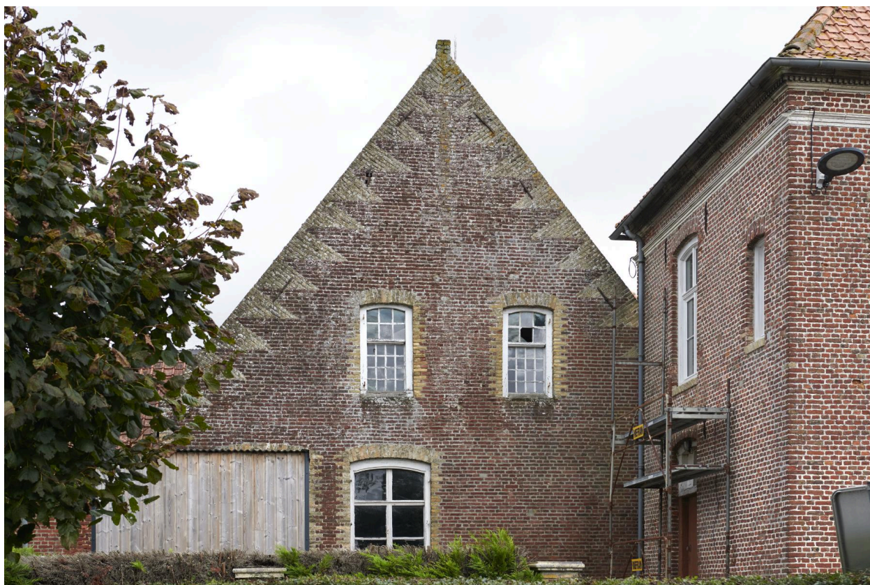
Logis principal. Détail du pignon ouest.
