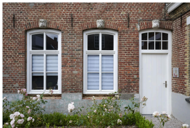
Détail des baies en rez-de-chaussée. Pavillon ouest. Façade sur cour. Phot. Delphine Volto Jourdan IVR32_20235901147NUCA
