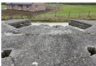
Depuis le toit, vers le sud, les sorties des cheminée à périscope et les encuvements des armes Phot. Jean-Marc Ramette IVR31_20145904065NUCA
