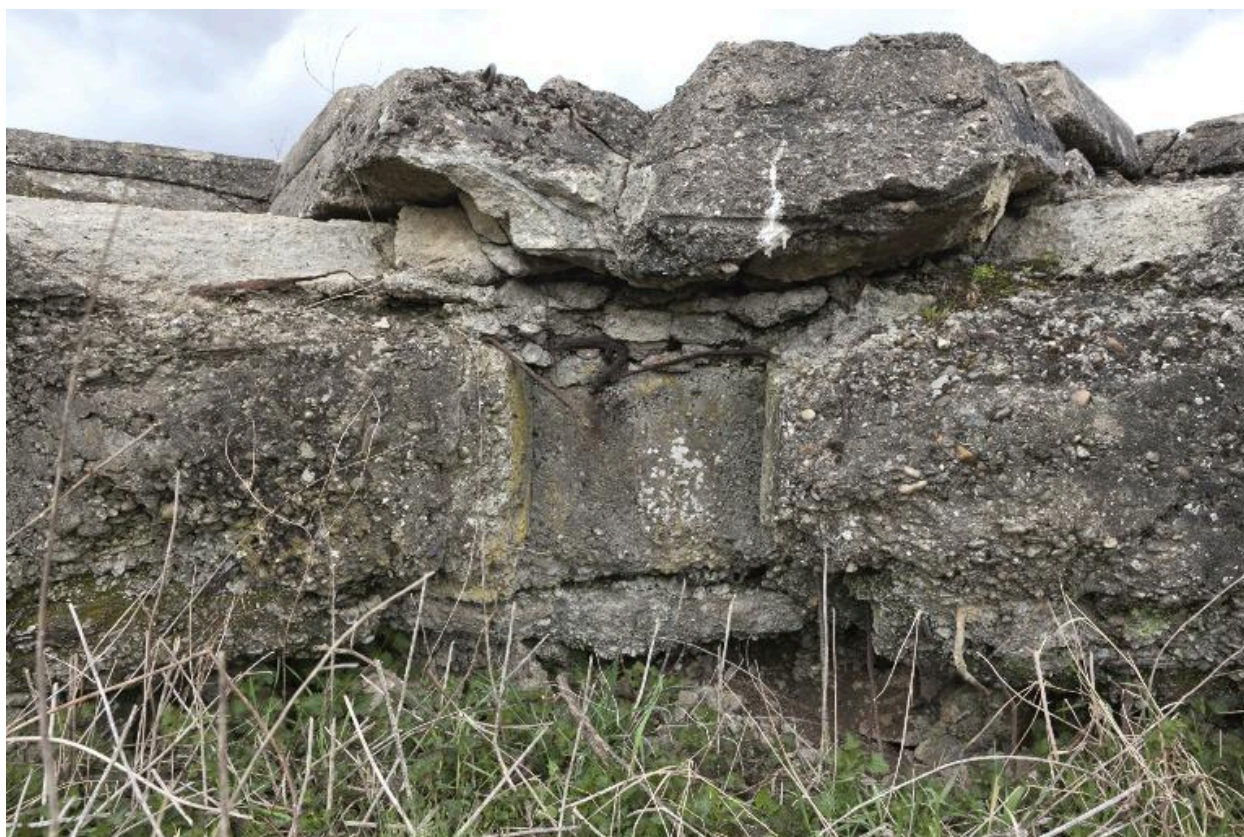
Elévation sud, partie centrale
