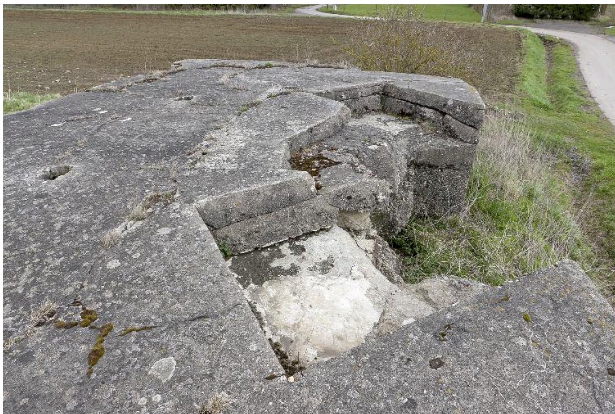
Depuis le toit, vue des logements d'armes
