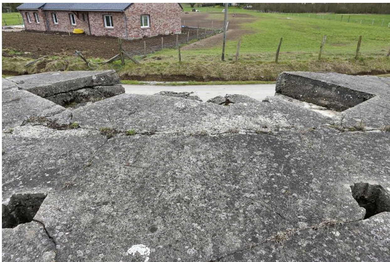
Depuis le toit, vers le sud, les sorties des cheminée à périscope et les encuvements des armes
