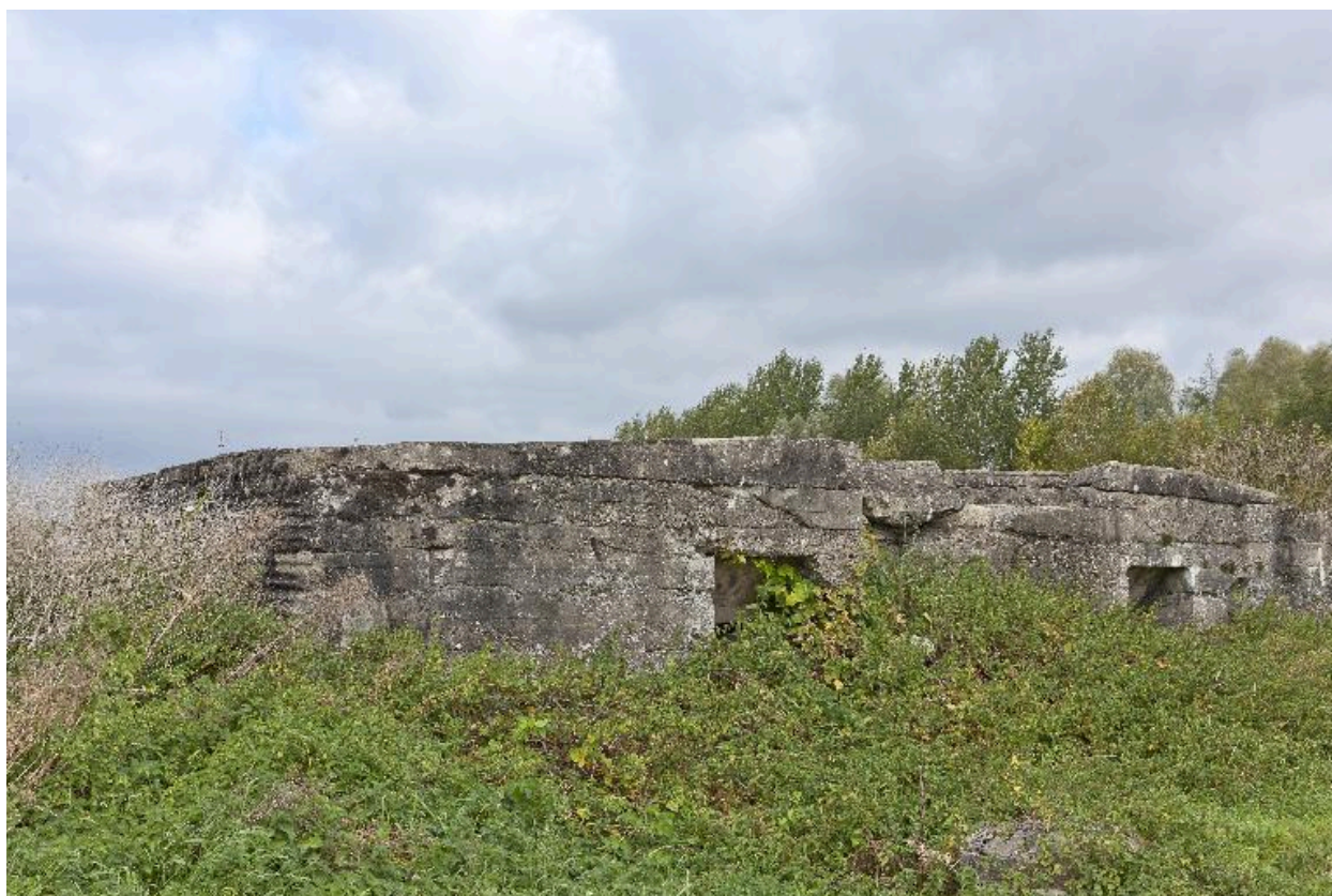
Elévation sud, ver le nord-est
