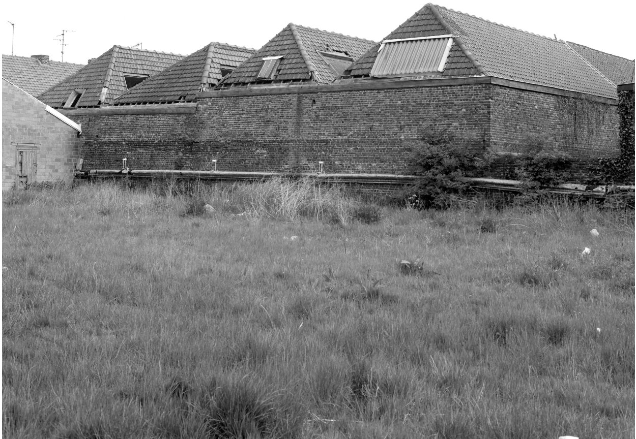
Atelier de fabrication, élévation postérieure.
