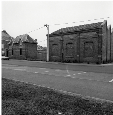
Magasin industriel, conciergerie. Phot. Philippe Dapvril IVR31_19885900845X
