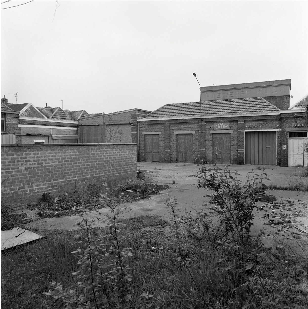
Atelier de fabrication, château d'eau depuis la cour.
