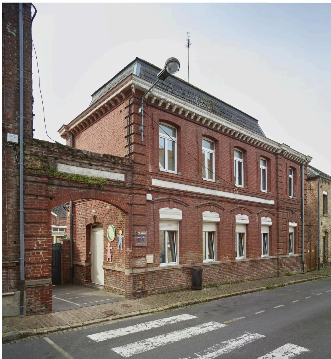
École maternelle du Centre : vue de la façade sur la rue Saint-François de la partie "ancienne salle d'asile" et du portail d'accès à la cour. Vue orientée ouest - est.
