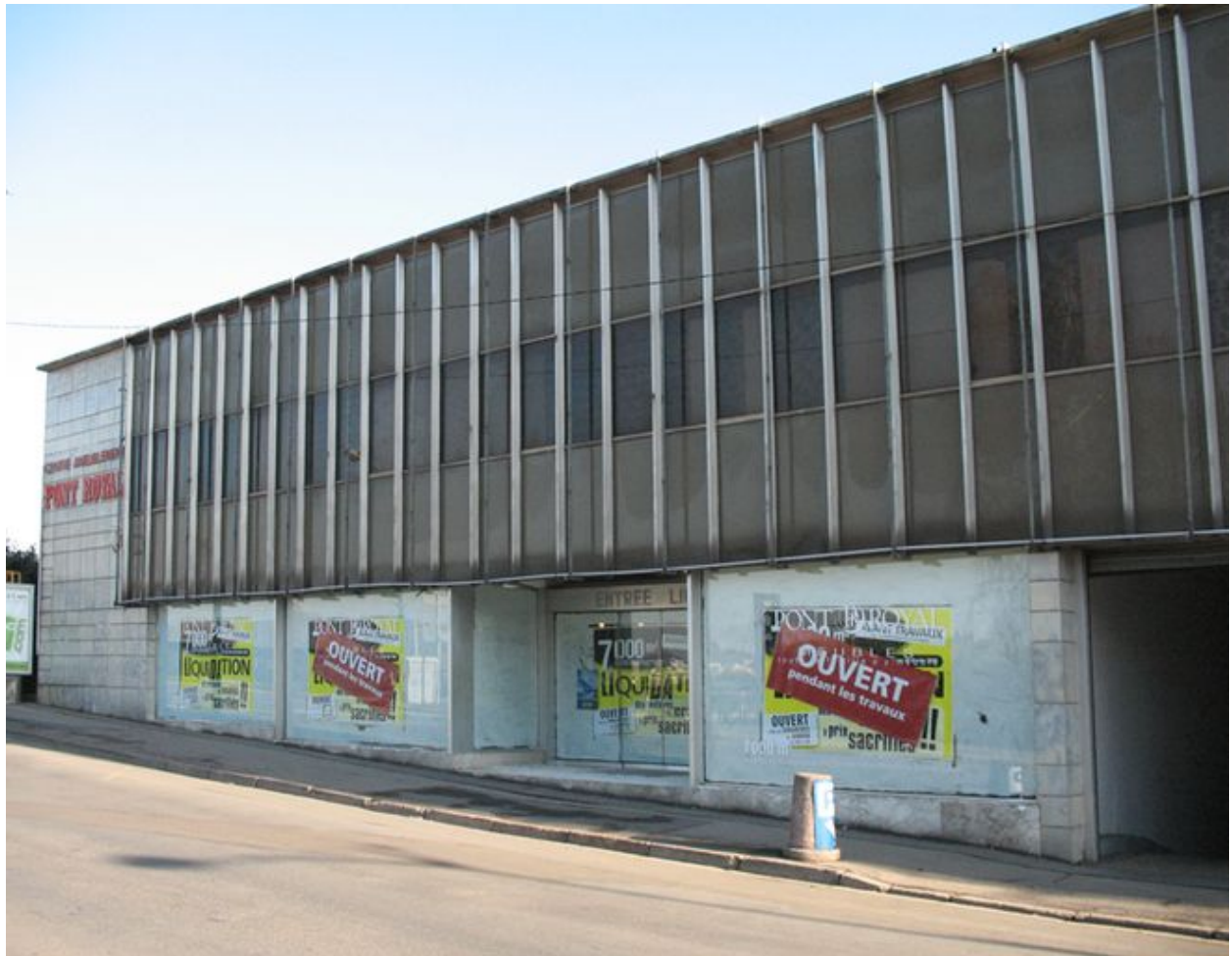
Détail de la structure verre et fer de la façade sur la rue Gambetta en février 2009.
