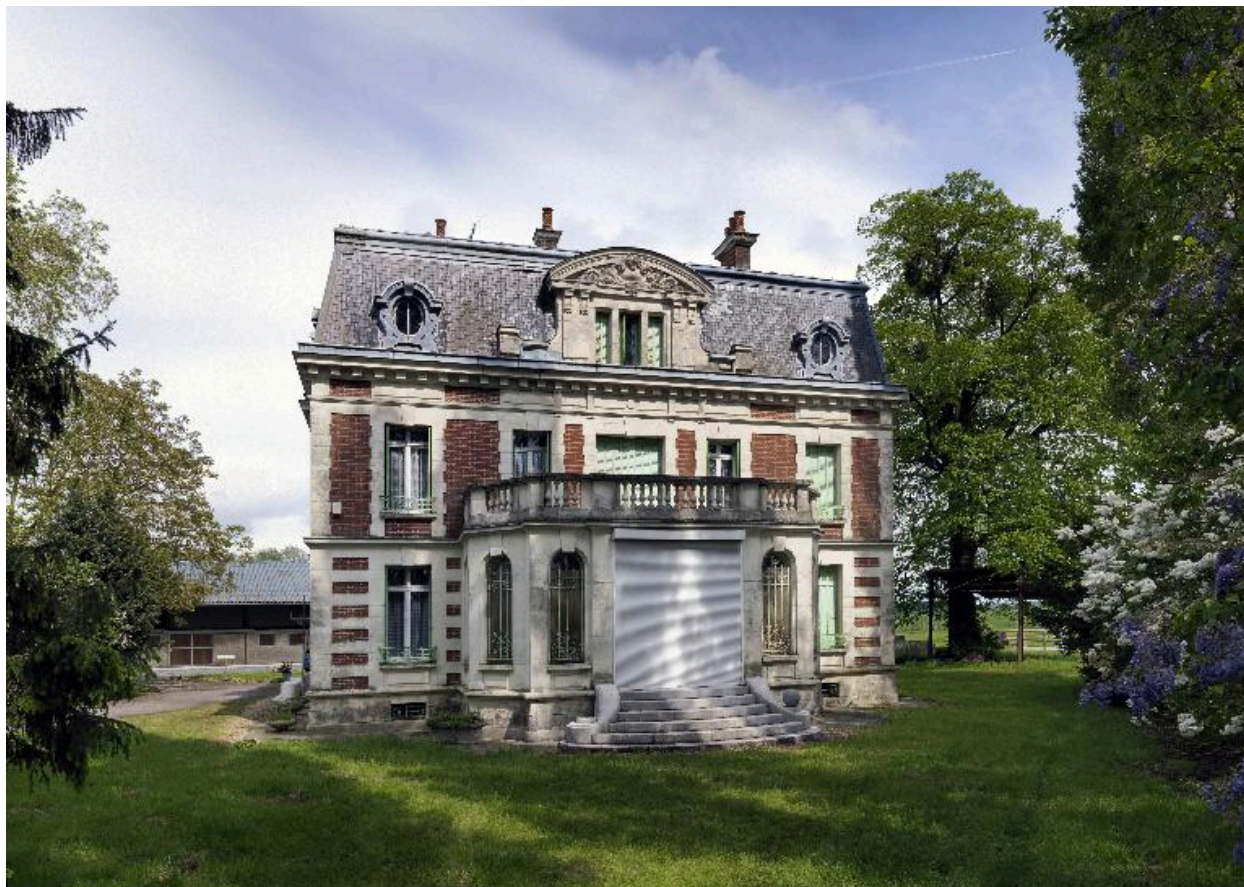
Vue de la façade du château.
