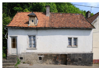
Façade sur rue, vue de face. Phot. Thierry Lefébure IVR22_20128000304NUC2A
