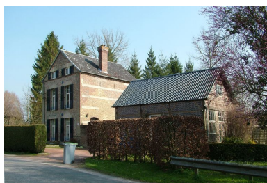
Vue générale depuis la rue. Phot. Frédéric Fournis IVR22_20098005075NUCA
