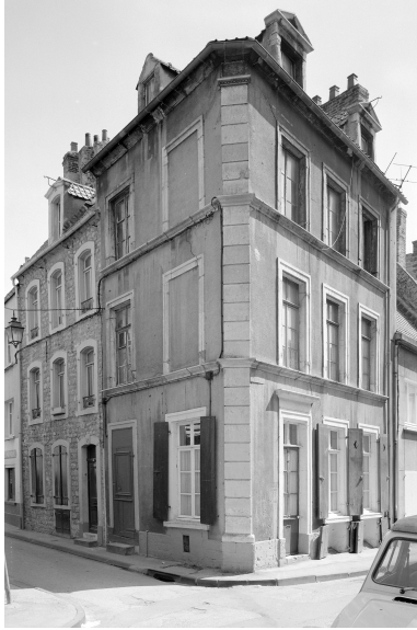
Vue générale sur voie. Phot. Éric Dessert, Phot. Jean-Michel Périn IVR31_19806202446X
