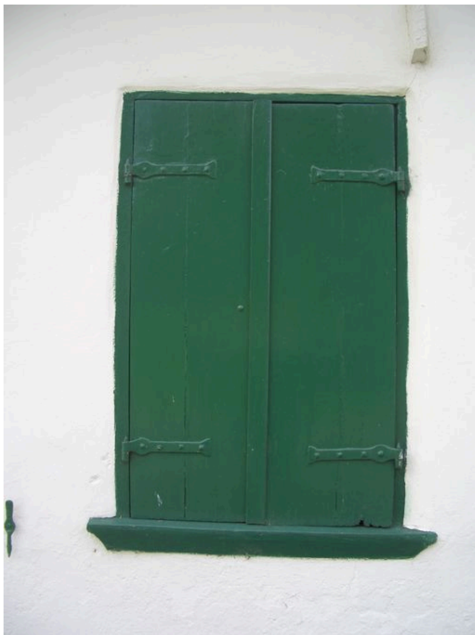
Détail du contrevent sur rue.
